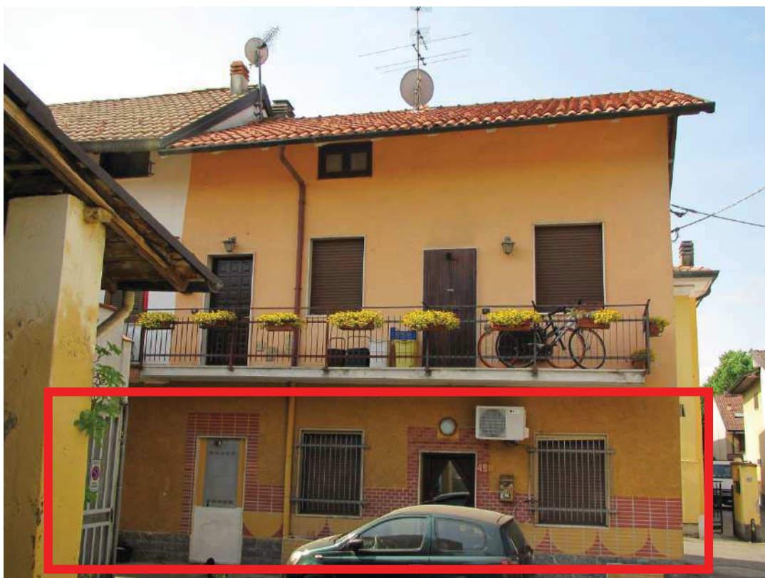
Fronte dell'edificio prospiciente la corte interna
