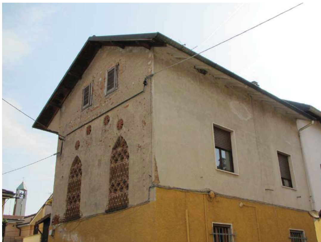
Fronte dell'edificio prospiciente Via Dante e fronte posteriore
