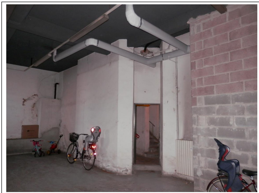
Fotografia n°10 – Vista dal laboratorio.
