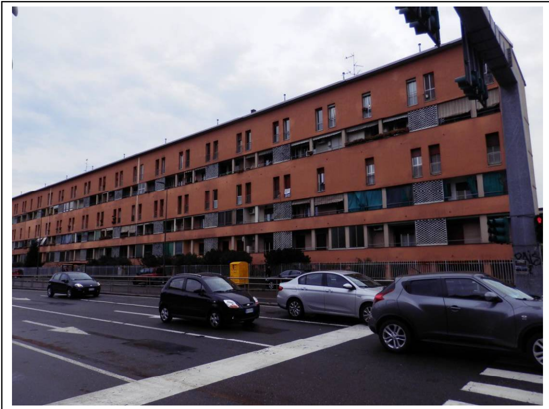
Fotografia n°1 – Vista del fabbricato residenziale.
