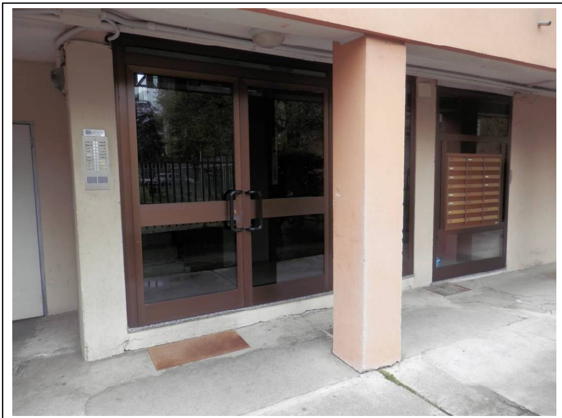
Fotografia n°4 – Vista del portone d'accesso al vano scala condominiale.
