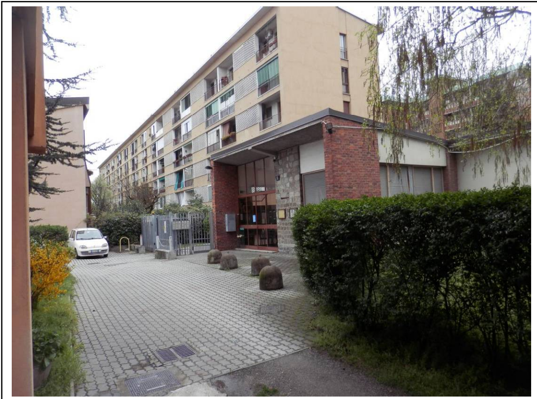
Fotografia n°3 – Vista del corpo di fabbrica destinato a portineria.
