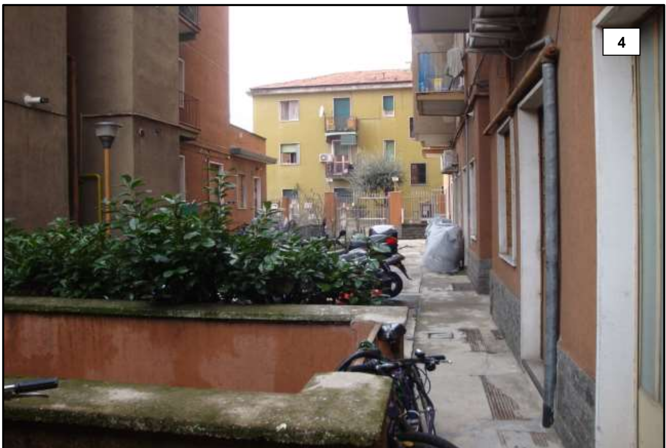
AREA CORTILIZIA INTERNA DI PERCORSO AL VANO SCALA (vista da ingresso comune)
