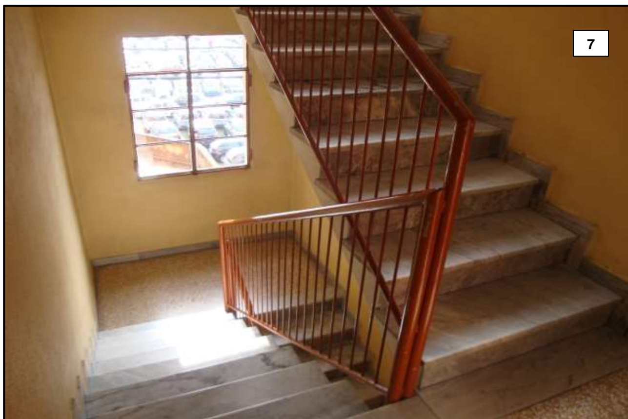
VANO SCALA (vista verso interpiano)
