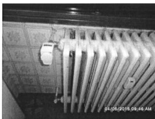
Radiatore con valvola e contabilizzatore
