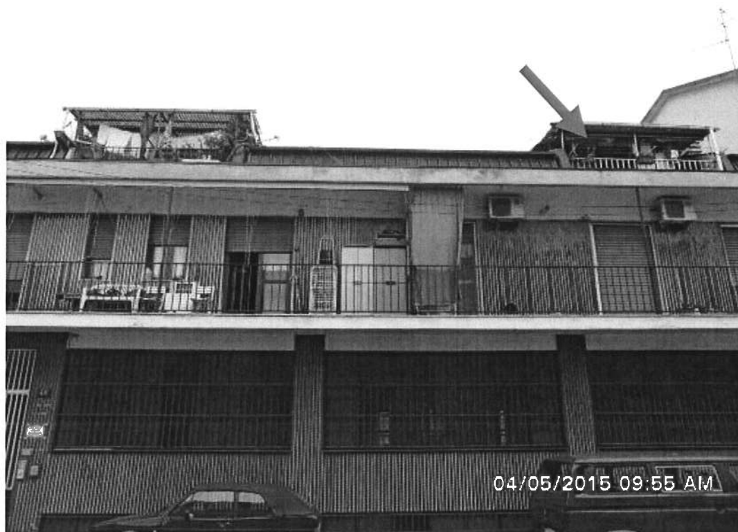
Facciata lato via Negrotto
