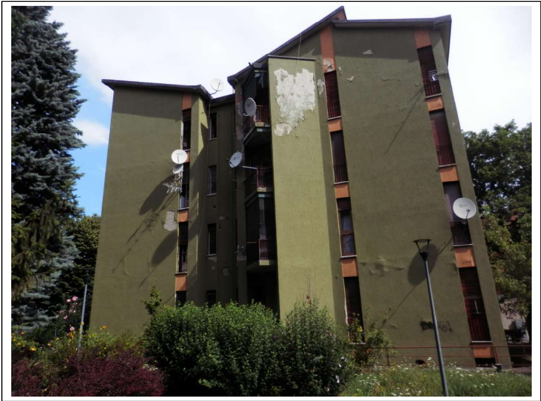
Fotografia n°1 – Vista del fabbricato residenziale.
