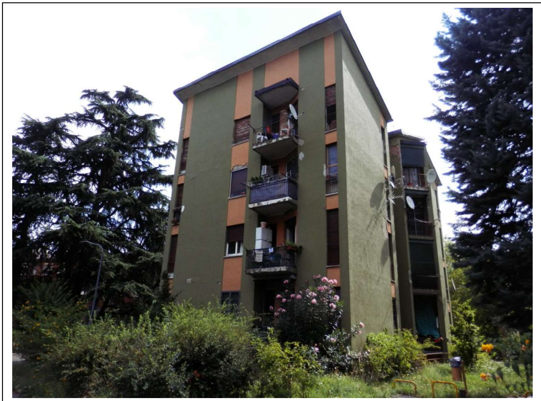
Fotografia n°2 – Vista del fabbricato residenziale.
