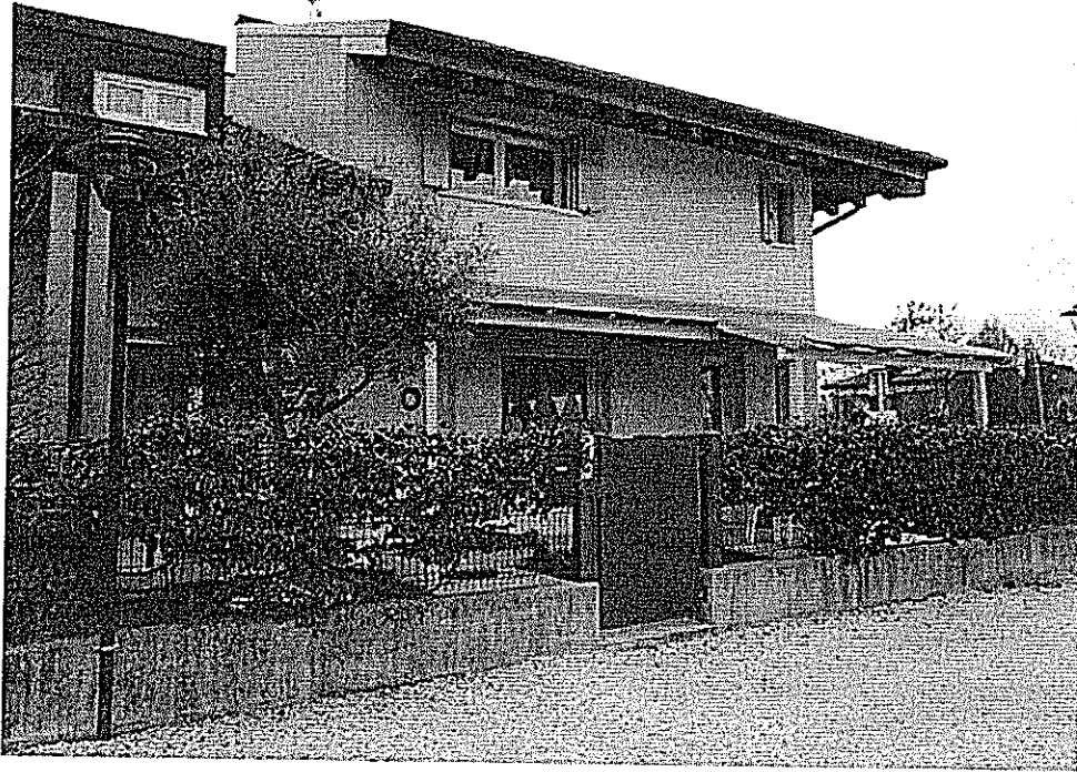
FOTO n°16. - LOTTO B2: visione esterna fabbricato
