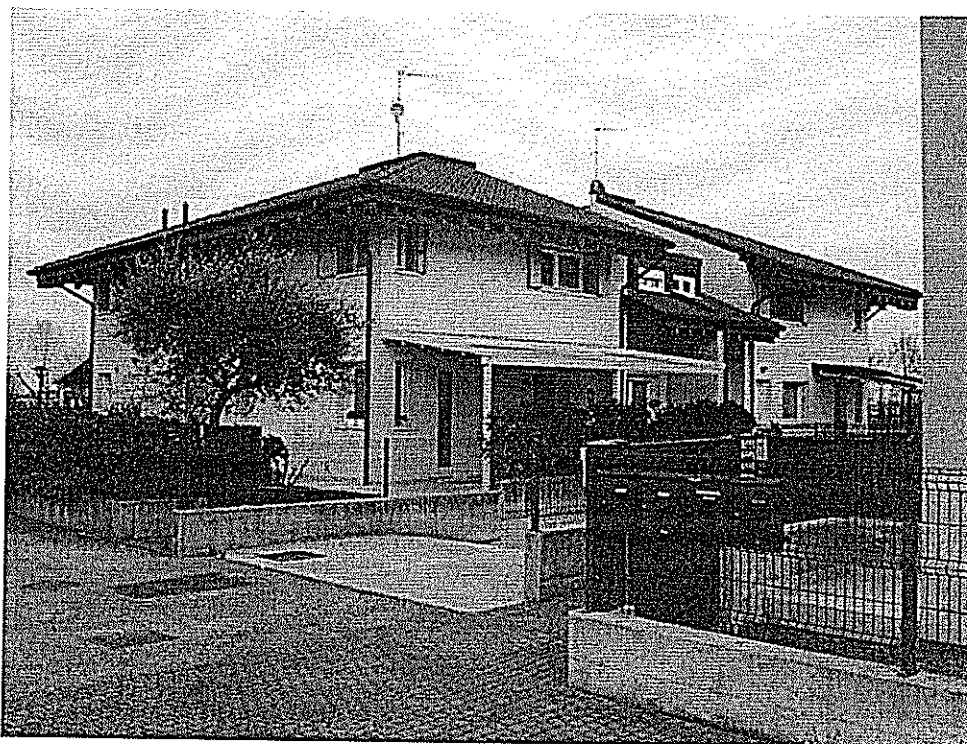
FOTO n°18. - LOTTO B2 : visione esterna fabbricato
