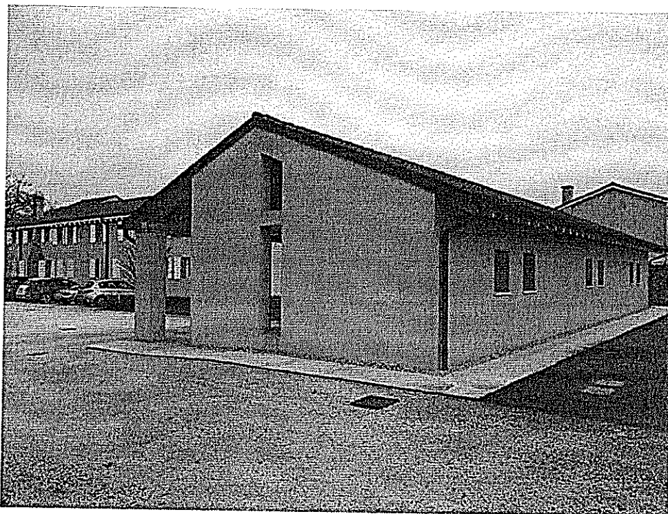
FOTO n°13. - LOTTO B1 - visione esterna fabbricato in corso di costruzione
