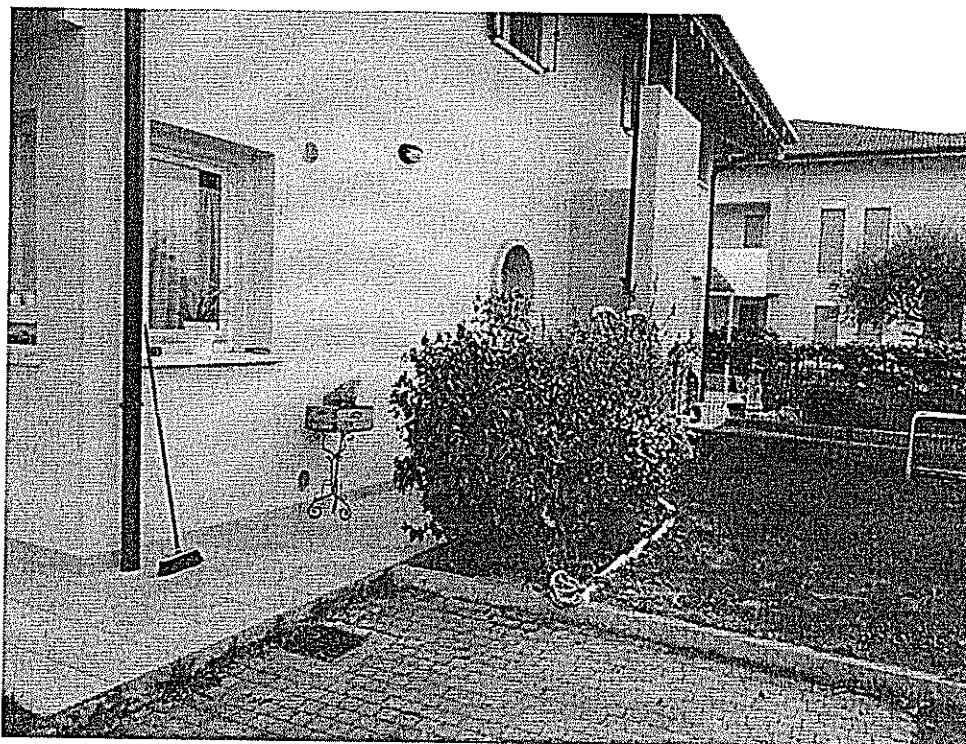
FOTO n°20. - LOTTO B2: visione area esterna fabbricato
