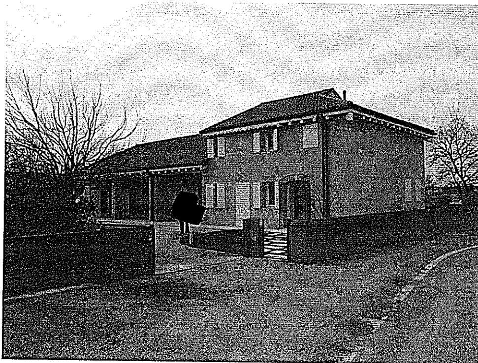
FOTO n°1. - LOTTO B1 - visione esterna fabbricato - facciata principale
