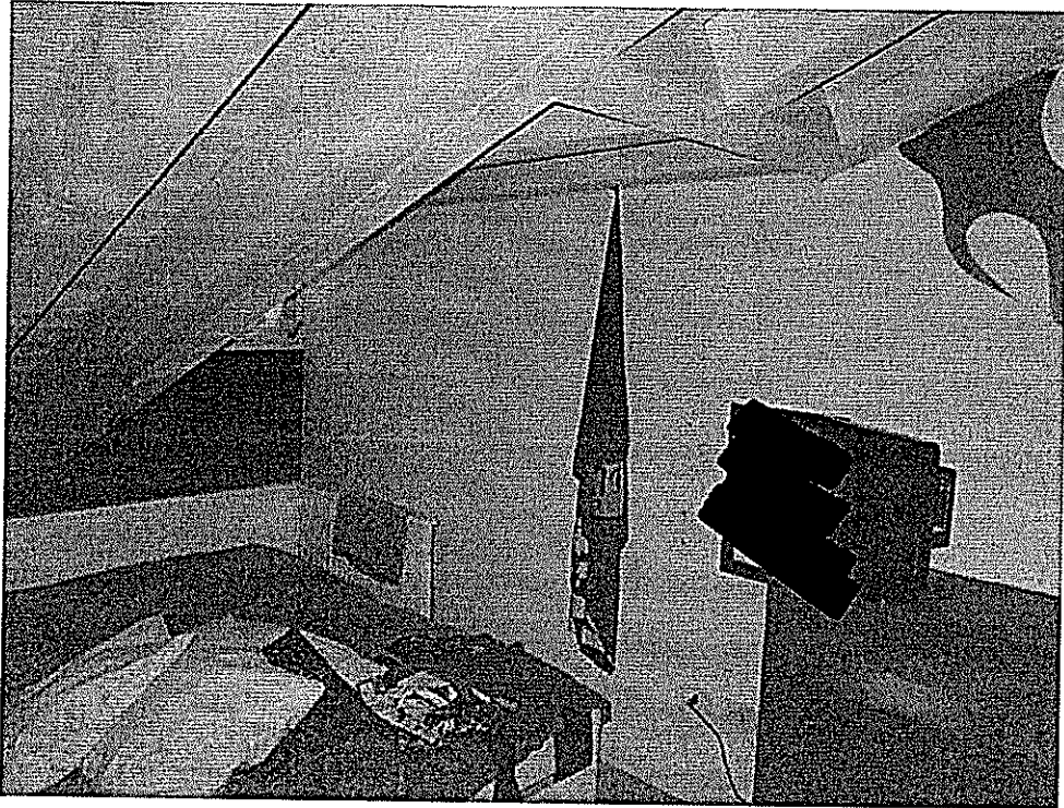
FOTO n°28. - LOTTO B2 : visione interna – piano primo
