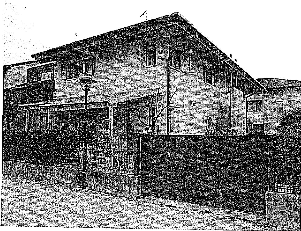
FOTO n°17. - LOTTO B2: visione esterna fabbricato
