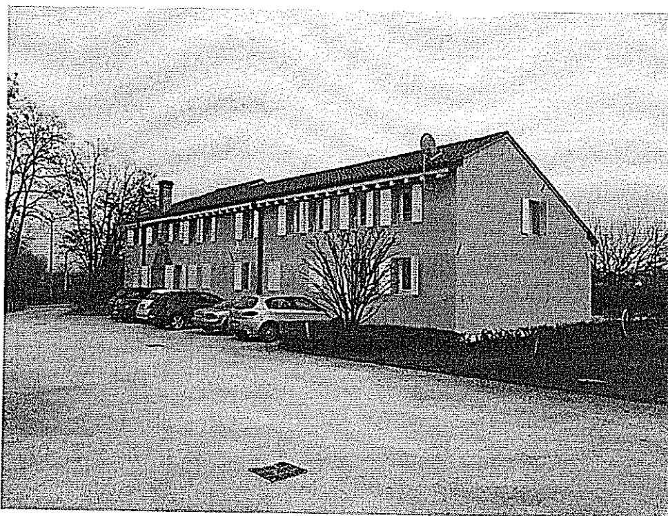
FOTO n°3. - LOTTO B1 - visione esterna fabbricato - facciata principale
