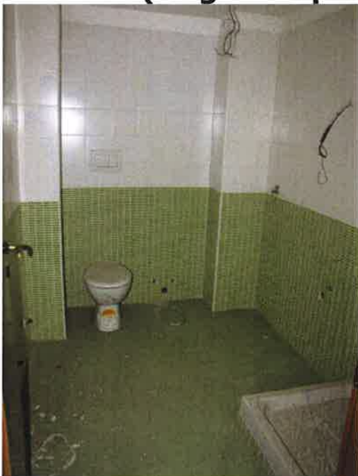
Foto 9- (Bagno al p.2°)
