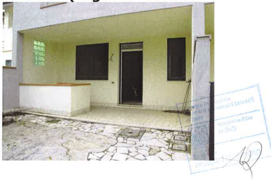
Foto 1 – (Ingresso con Corte Esclusiva)
