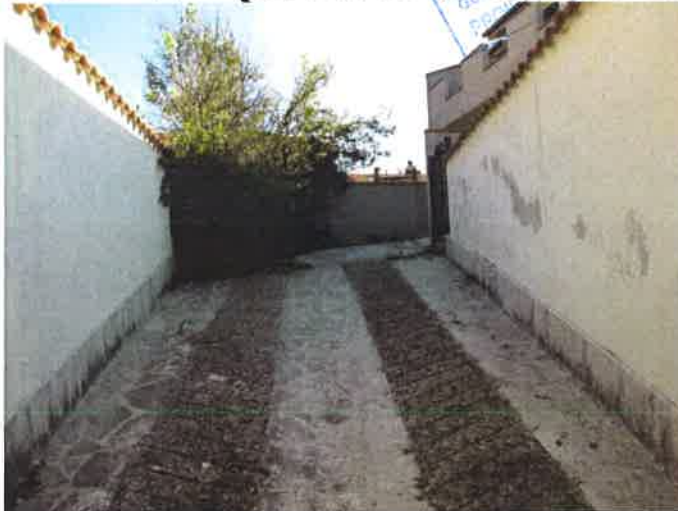
Foto 11- (area di accesso comune)
