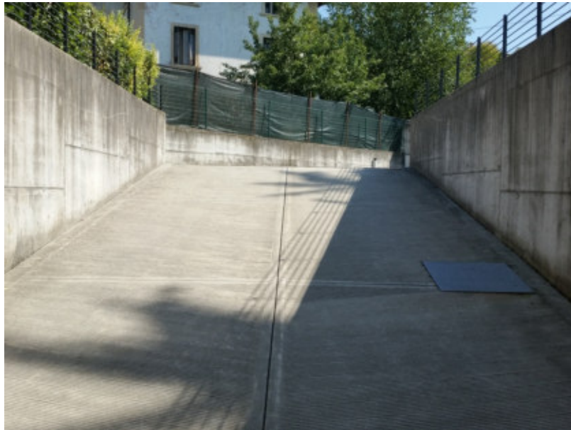
Rampa di accesso all'interrato
