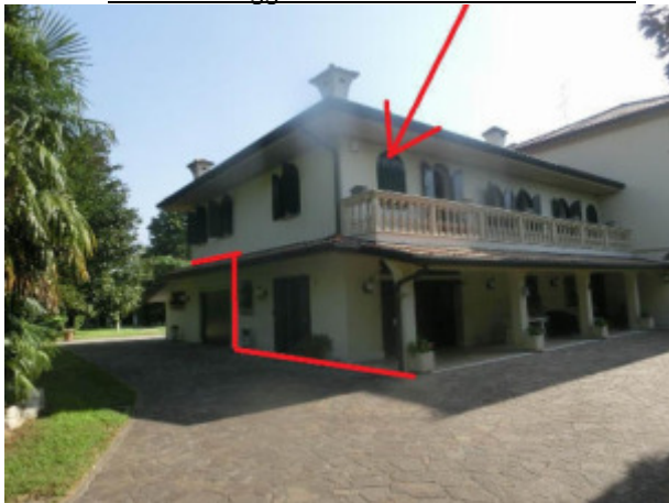
Prospetto Sud-Ovest del fabbricato
