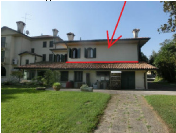
particolare prospetto Nord
