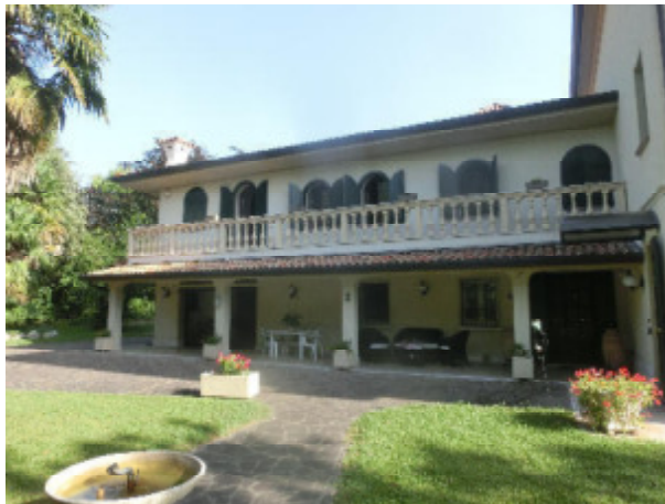
particolare prospetto Sud del fabbricato
