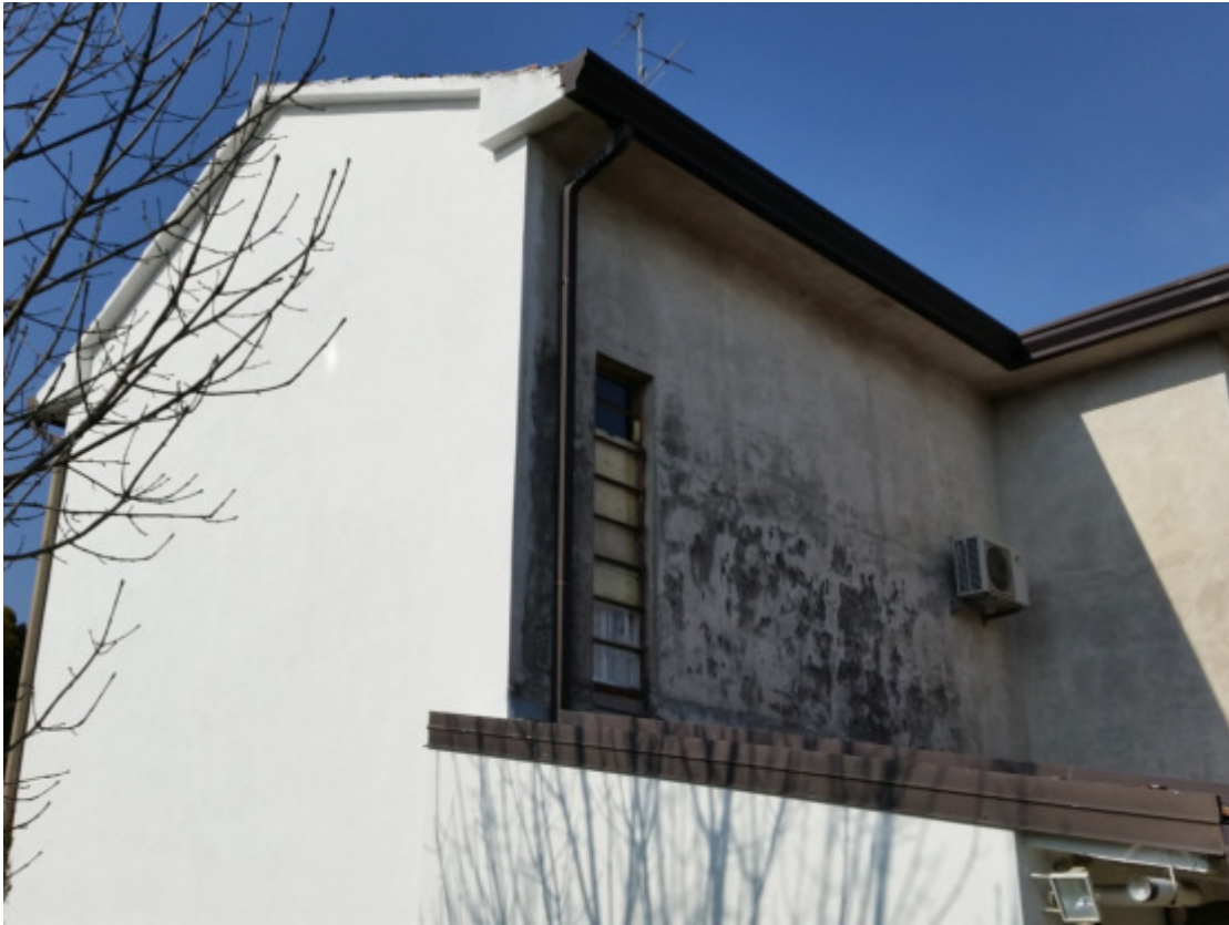
Facciata fabbricato sul lato opposto a via Manzoni
