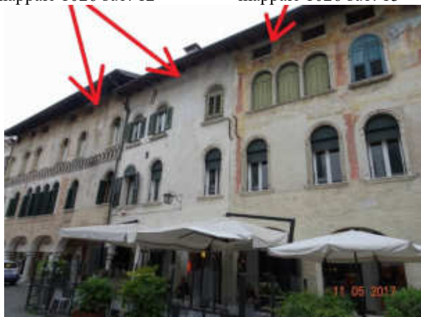
particolare prospetto da Corso Vittorio Emanuele II
