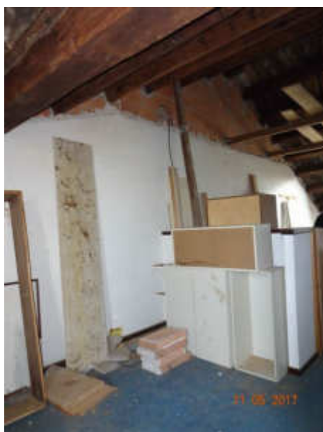
particolare zona camera
