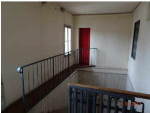
particolare porta d'ingresso al sub. 13
