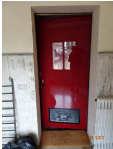
particolare porta d'ingresso al sub. 12
