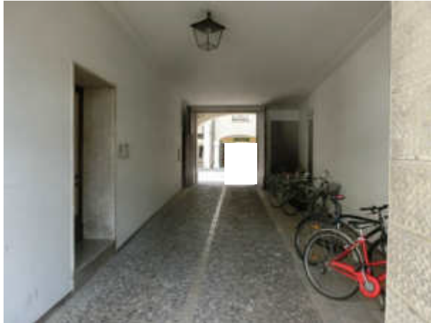
particolare ingresso comune (mappale 1026 sub. 27)
