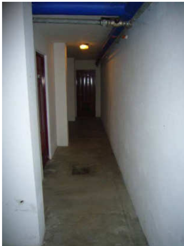
CORRIDIOIO CANTINE COMUNE
