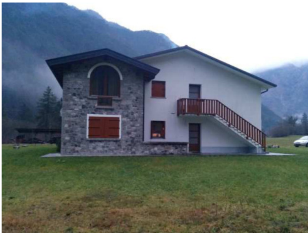
FOTO 26: PANORAMICA LATERALE E SCALE ACCESSO SUB. 2
