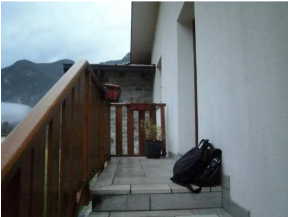
FOTO 28: INGRESSO UNITA' AL PIANO PRIMO (Subalterno n. 2)
