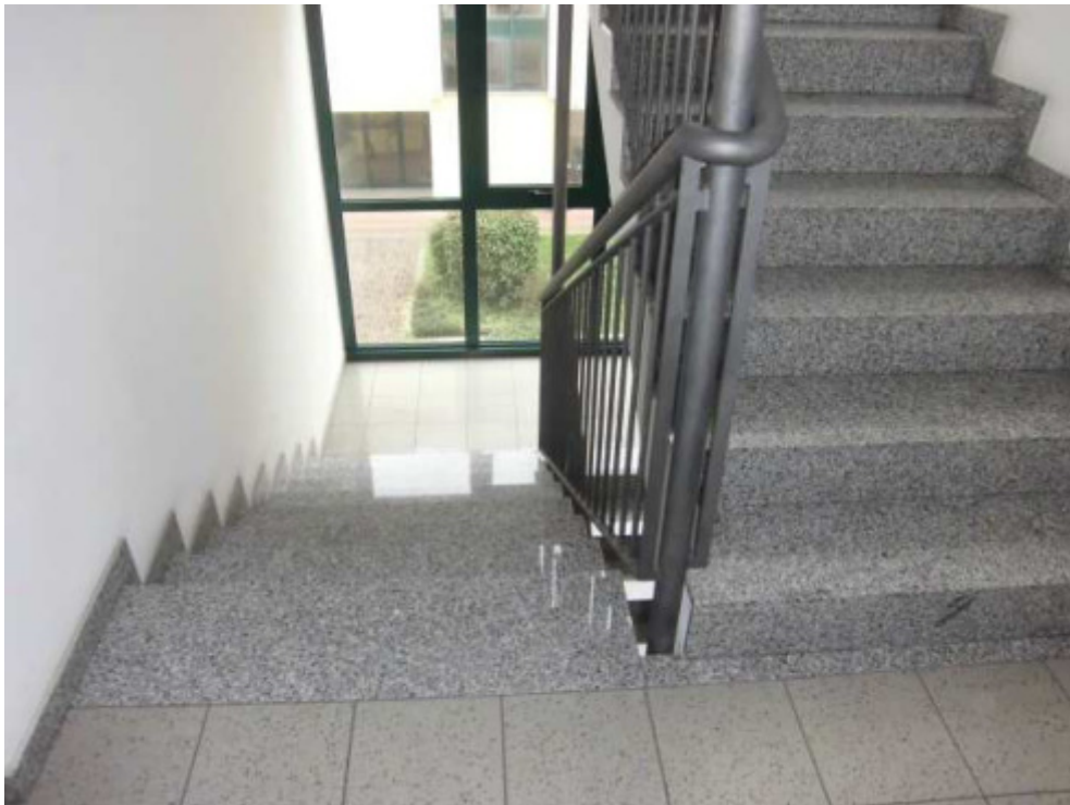
FOTO 6: VANO SCALE CONDOMINIALE
