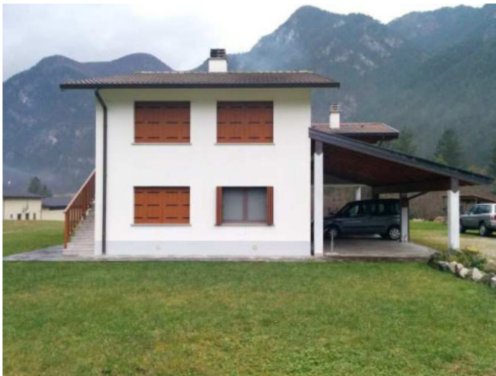
FOTO 25: PANORAMICA FRONTALE ABITAZIONE INTERA (Sub. 2 e 1)
