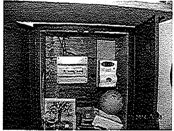
Quadro elettrico generale (garage)
