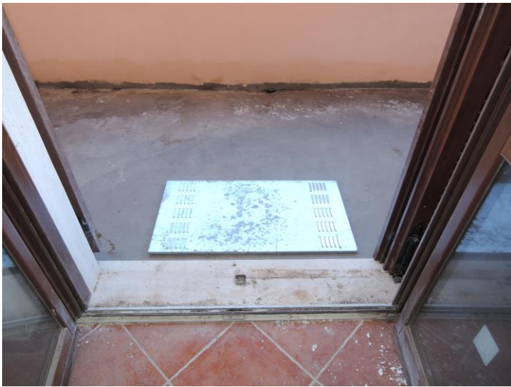
Balcone di pertinenza del vano soggiorno al piano primo con pavimentazione mancante e non ultimata
