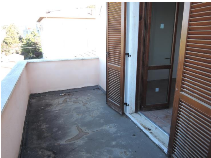
Balcone di pertinenza della Camera lato Ovest del piano secondo (a valle) con pavimentazione mancante e non ultimata
