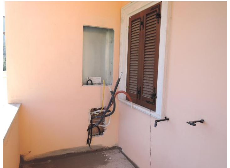
Balcone di pertinenza del vano cucina al piano primo con pavimentazione mancante e non ultimata
