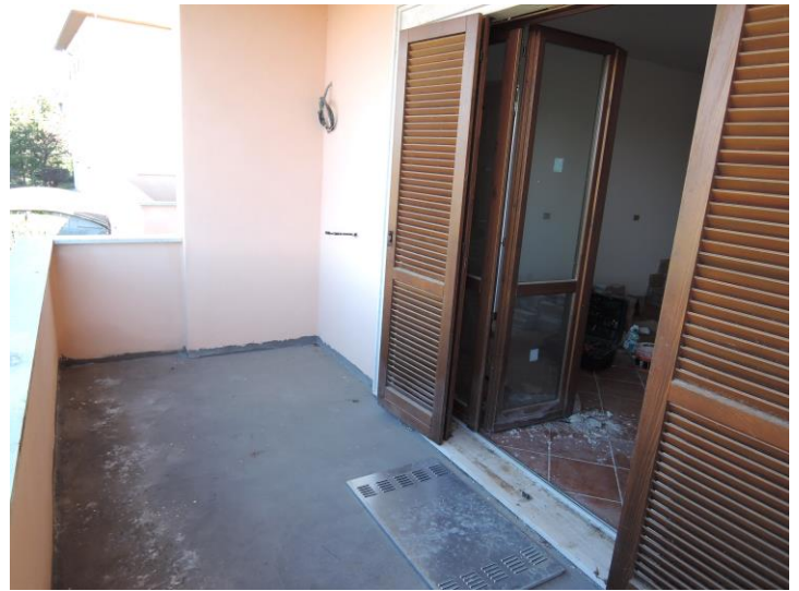
Balcone di pertinenza del vano soggiorno al piano primo con pavimentazione mancante e non ultimata
