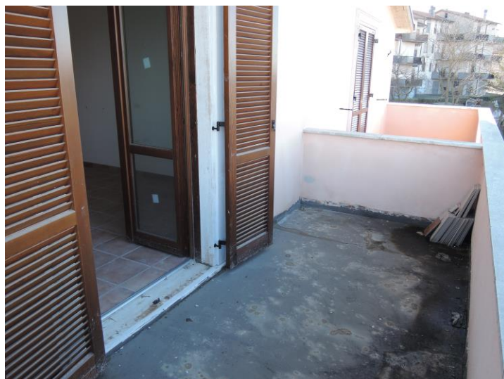
Balcone di pertinenza della Camera lato Ovest del piano secondo (a valle) con pavimentazione mancante e non ultimata
