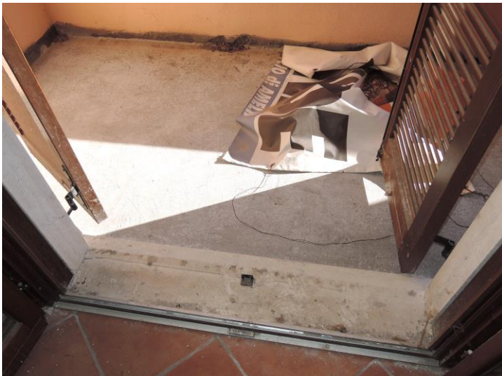
Balcone di pertinenza del vano cucina al piano primo con pavimentazione mancante e non ultimata
