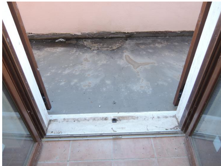
altro vano Camera posto sul lato Ovest al piano secondo e Balcone di pertinenza (a valle) con pavimentazione mancante e non ultimata
