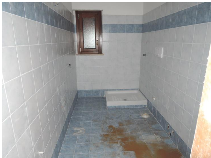
Vano Bagno al piano secondo (con finestra spostata a sinistra)
