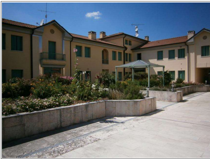
Foto 10 – corte condominiale interna
