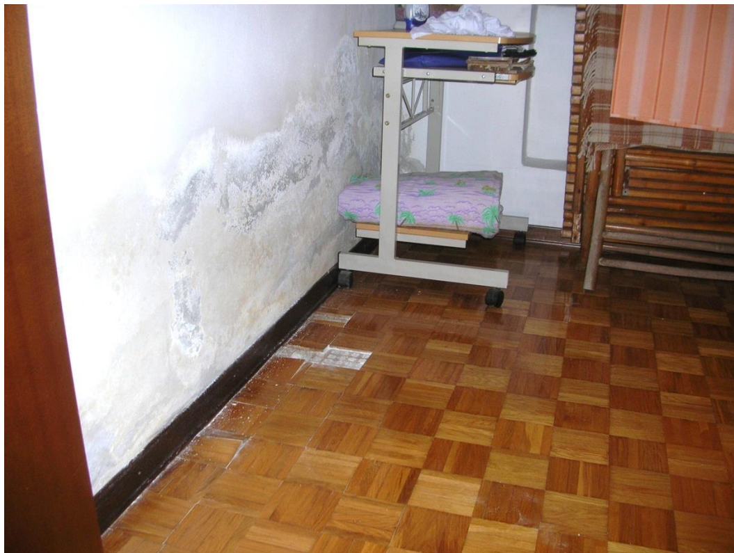
Ex perdita bagno e parchetti sconnessi dall'umidità
