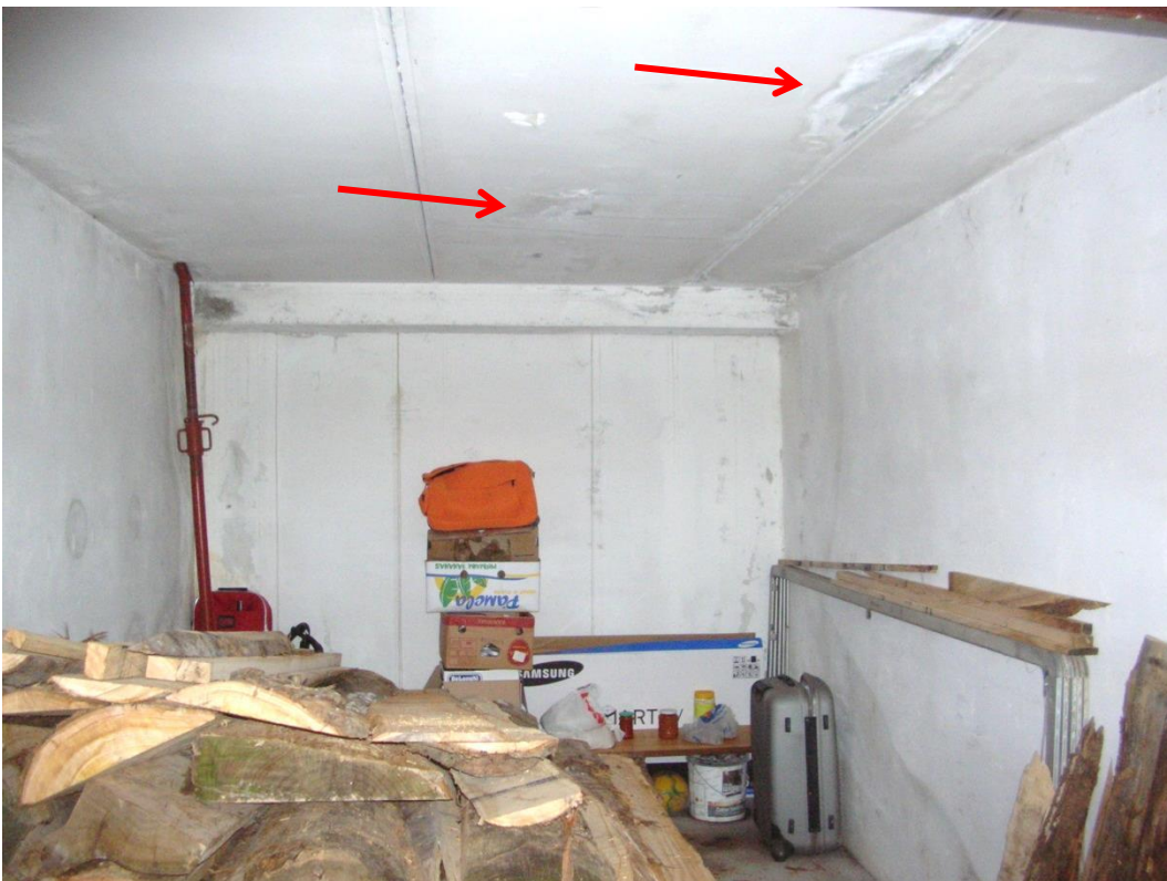
Autorimessa – infiltrazioni d'acqua dal solaio piano terra
