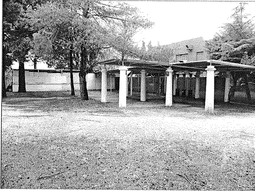
Casa del Diavolo, Perugia (PD): #02-ex discoteca all'aperto (area ballo e costruzioni in precario)
