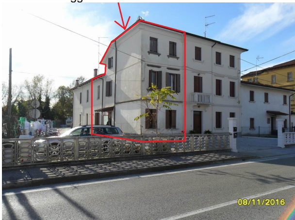
Particolare accesso e prospetti del fabbricato -lato Nord/Est-
