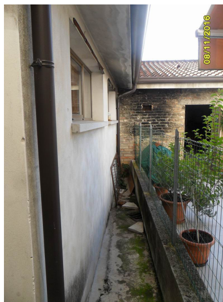
particolare area esterna esclusiva -lato Ovest-
