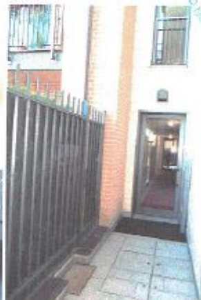
Foto 5 - parti comuni accesso al corpo scala
