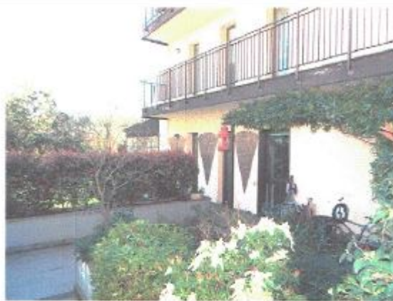
Foto 31- ingresso all'unità immobiliare dal giardino in uso esclusivo
