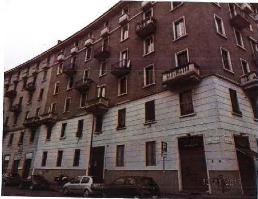
Vista esterna - ingresso pedonale fronte strada
