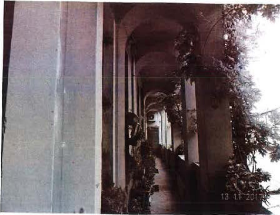
Vista esterna - ballatoio comune
