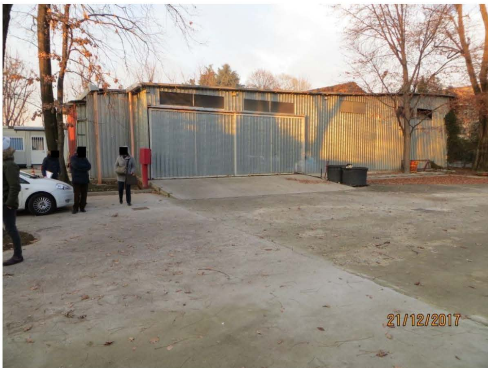
Foto 6 - Costruzione metallica ad uso autofficina meccanica (da rimuovere ai fini della trasformazione del terreno in comparto edilizio)
