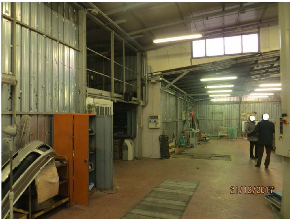
Foto 10 – Costruzione metallica ad uso autofficina meccanica (da rimuovere ai fini della trasformazione del terreno in comparto edilizio)
