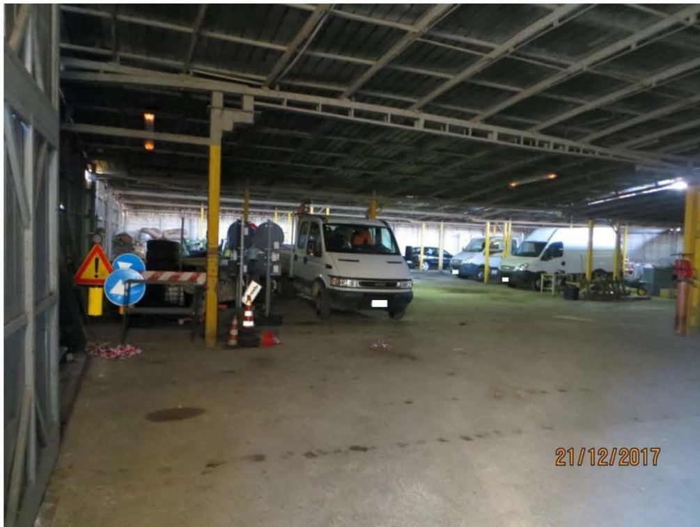
Foto 24 – Costruzione metallica adibita a rimessa (da rimuovere ai fini della trasformazione del terreno in comparto edilizio)
