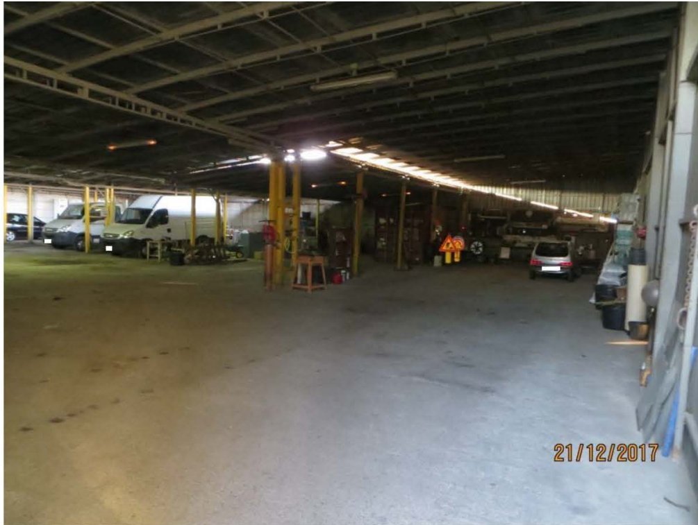
Foto 23 – Costruzione metallica adibita a rimessa (da rimuovere ai fini della trasformazione del terreno in comparto edilizio)
