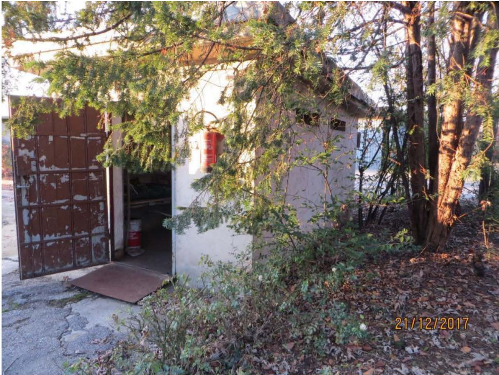
Foto 17 – Piccolo fabbricato in muratura per deposito attrezzi (particella 179) (da rimuovere ai fini della trasformazione del terreno in comparto edilizio)
