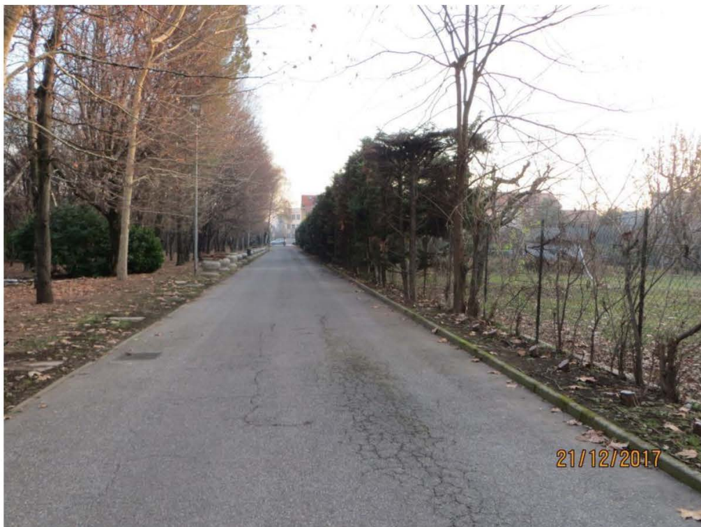
Foto 2 – Veduta, verso via Litta Modignani, del percorso di accesso al compendio pignorato Dalla lettura del rogito si rileva: "Accesso e scarico per servitù di passo dipartentesi dalla via Litta Modignani, passo pedonale e carraio attraverso i mappali 53 e 29"
