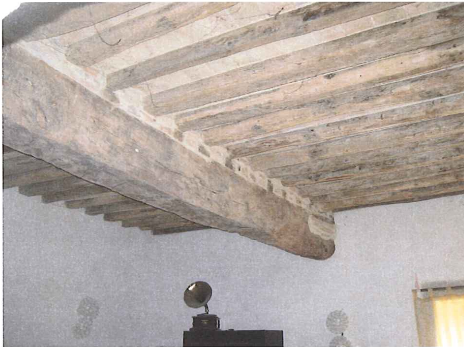
Illustrazione 28: Particolare solaio interpiano piano primo camera 1
