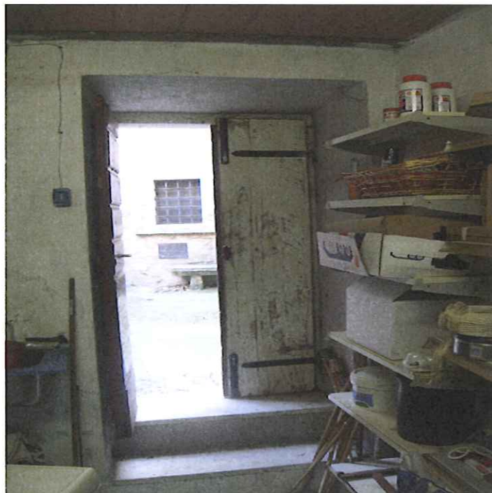
Illustrazione 47: Particolare magazzino 1 al piano terra
