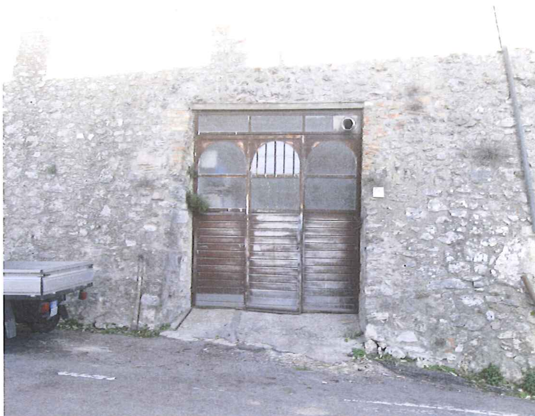
Illustrazione 10: Particolare portone d'ingresso in ferro e vetro lungo il lato sud per accedere al laboratorio
