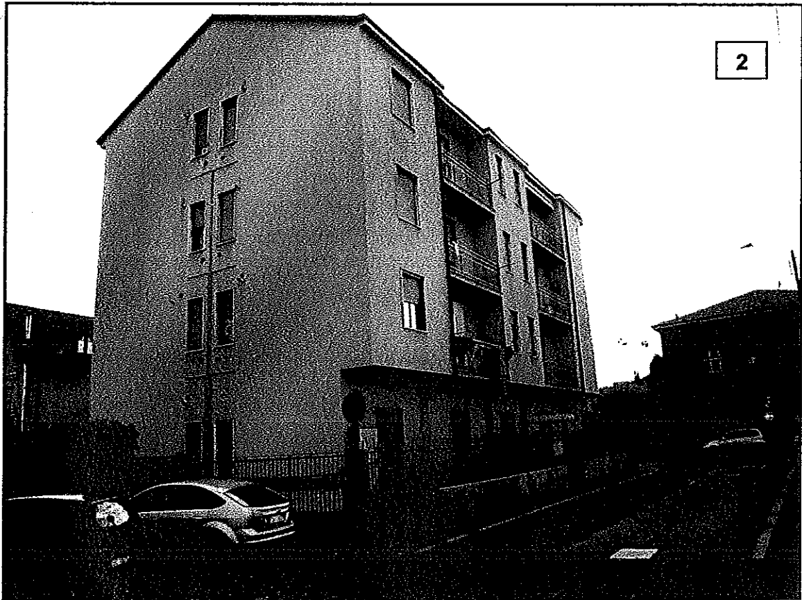
VISTA GENERALE ESTERNA LATERALE da VIA F. FILZI
