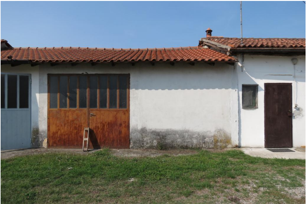
Vista ingresso magazzino dalla corte.
