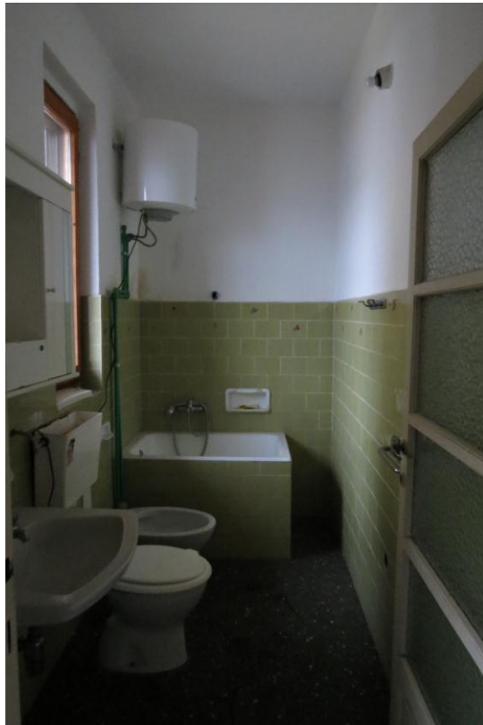
Locale bagno al piano primo.
