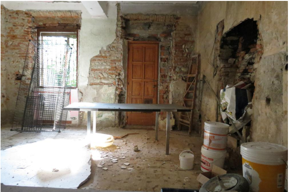
Vista interna del locale al piano terra
