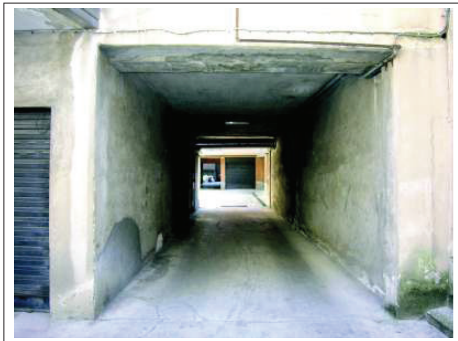
Vista del cortile condominiale e vista del sottopassaggio tra gli edifici.
