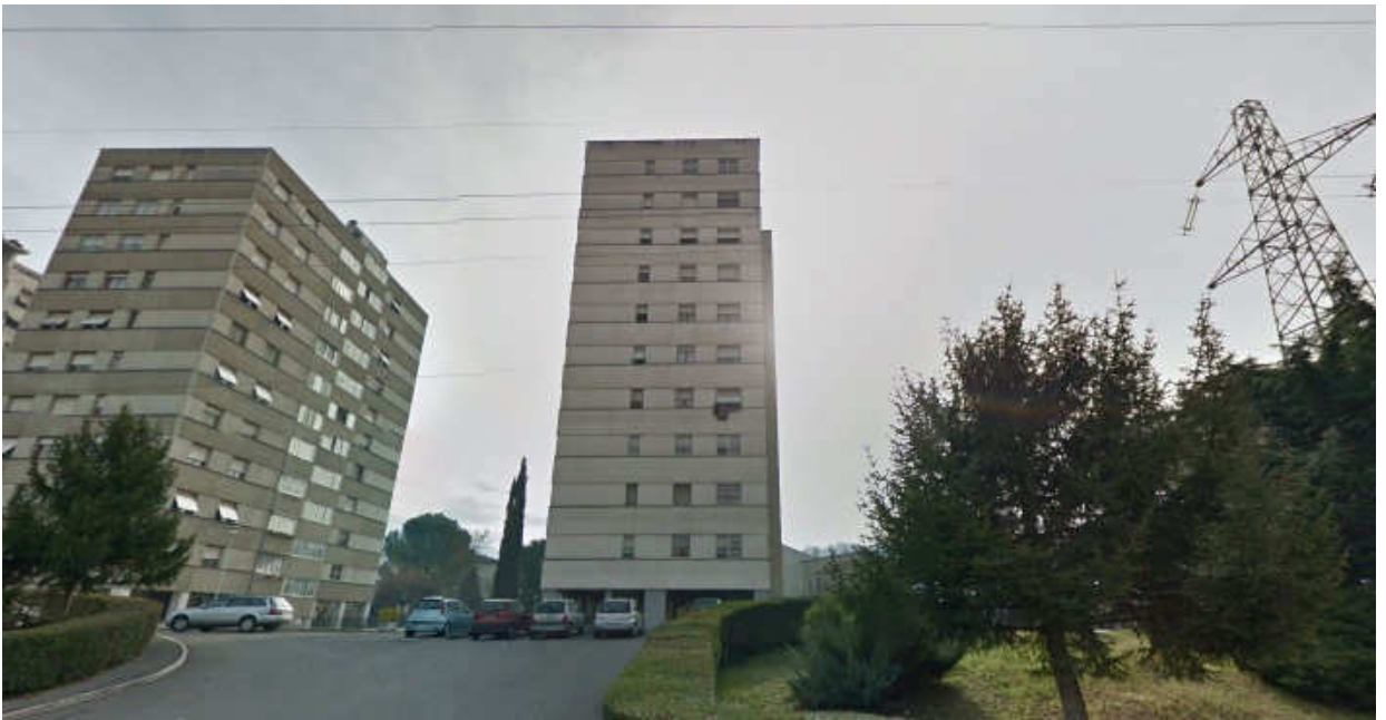
ingresso al parcheggio condominiale
