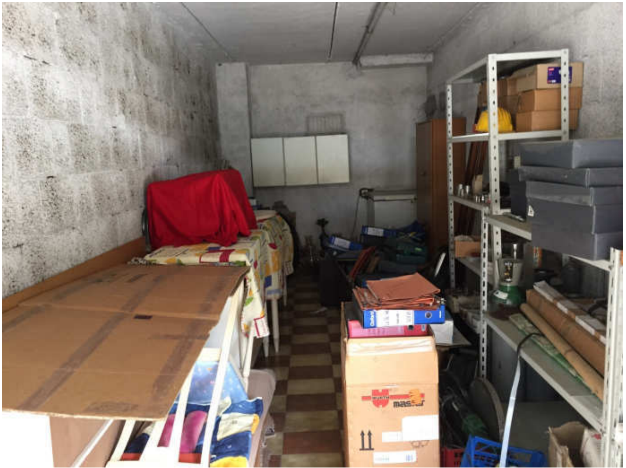
interno del garage
