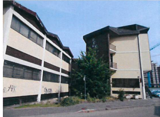
2. Vista laterale dei due fabbricati
