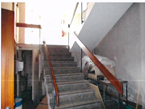
15. Scale di accesso al piano interrato
