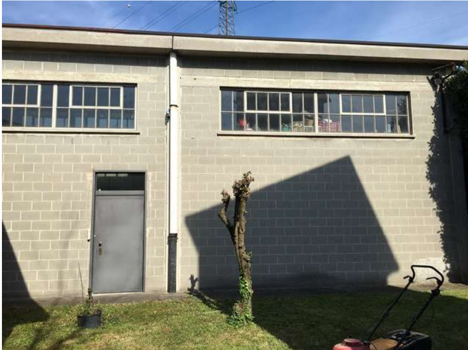
Ripostiglio e caldaia Settimo Milanese Milano
