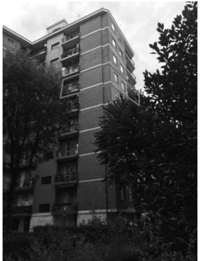
Vista del Fabbricato dal cortile interno
