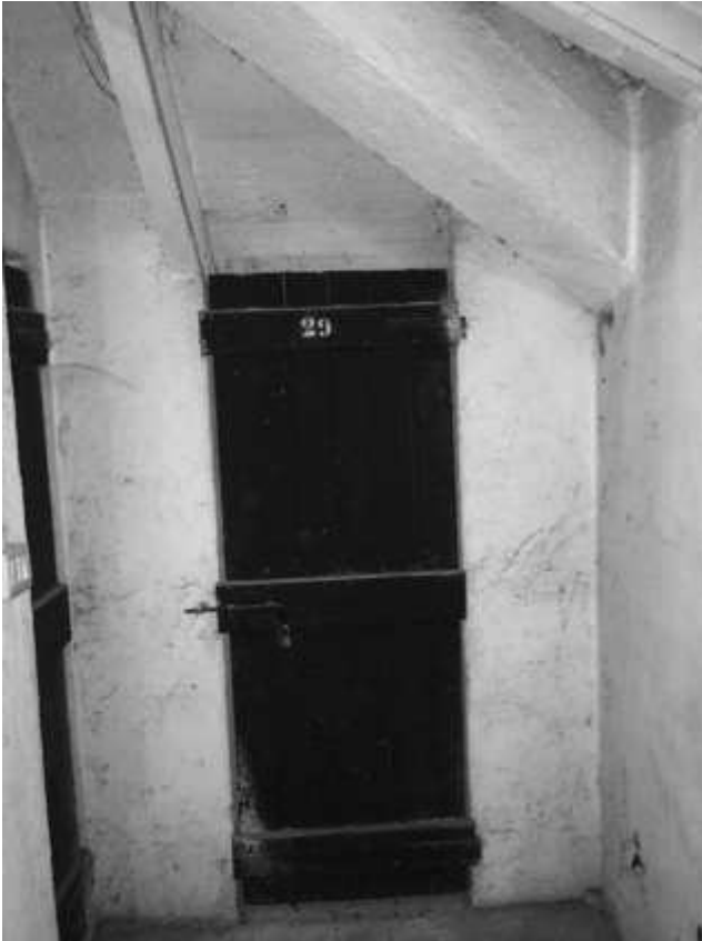
Vista porta solaio
