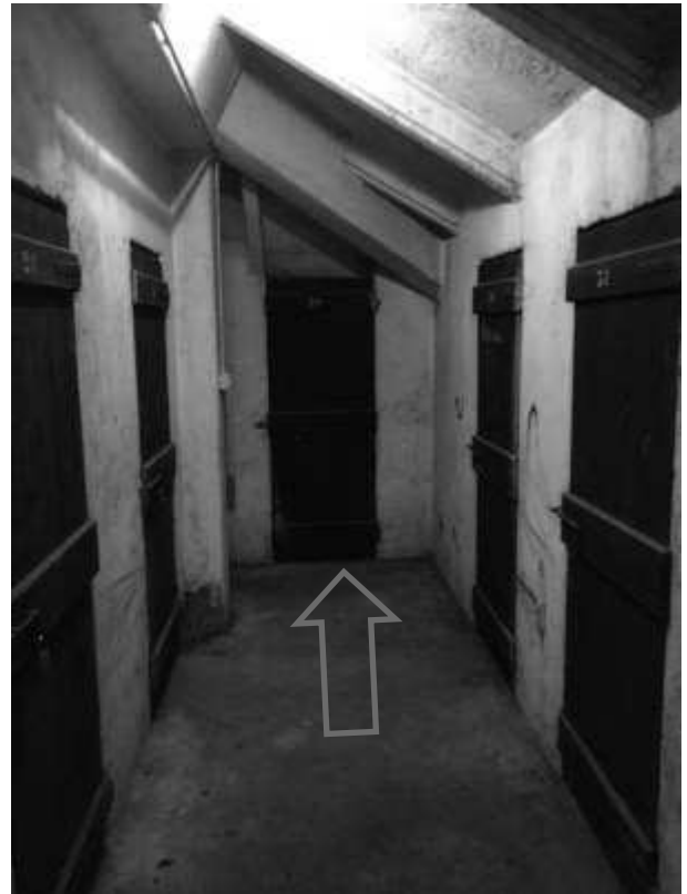
Vista corridoio solai
