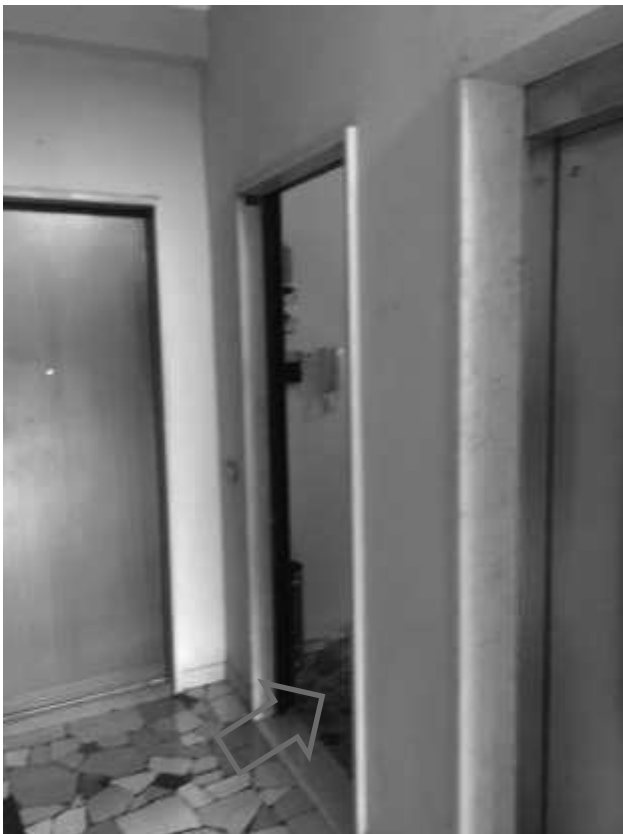
Vista pianerottolo d'ingresso
