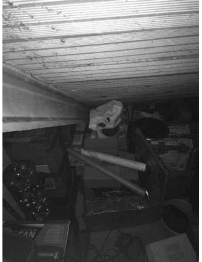
vista interno solaio
