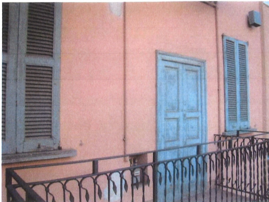
Fotografia n. 12 – Via Padova n. 151 Milano: particolare del ballatoio
