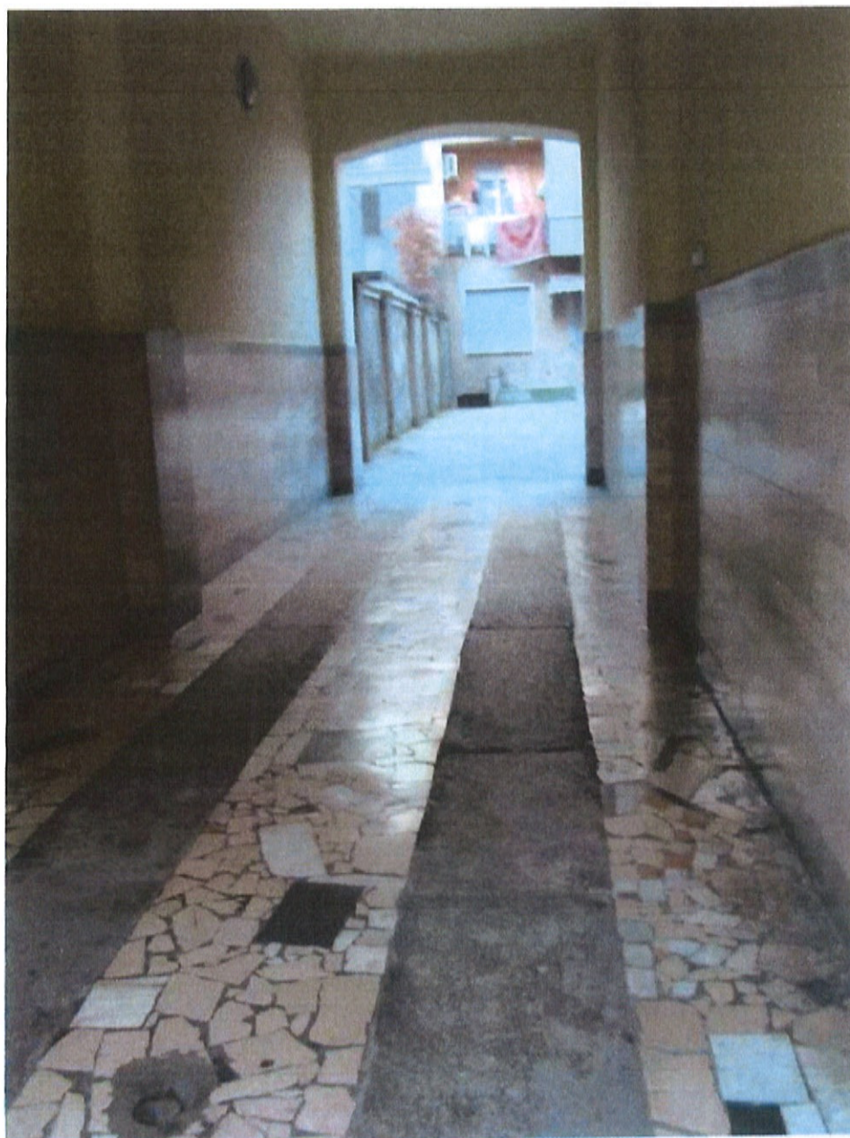
Fotografia n. 6 – Via Padova n. 151 Milano: vista del passaggio carraio verso il cortile interno
