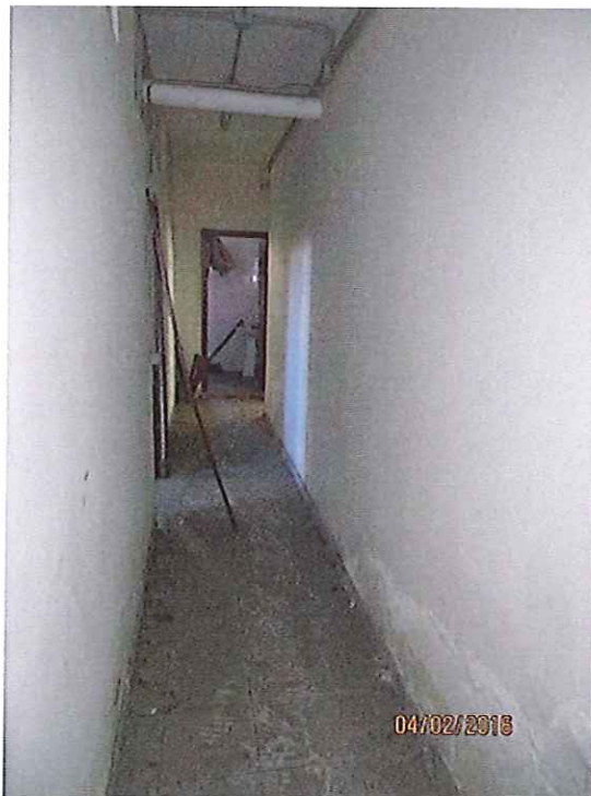
Foto 11 - Vista del corridoio
