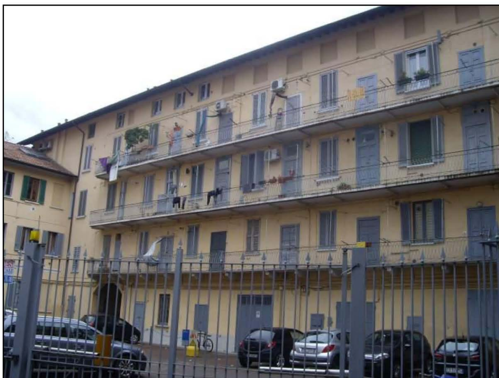
Edificio in esame - prospetto su corte interna
