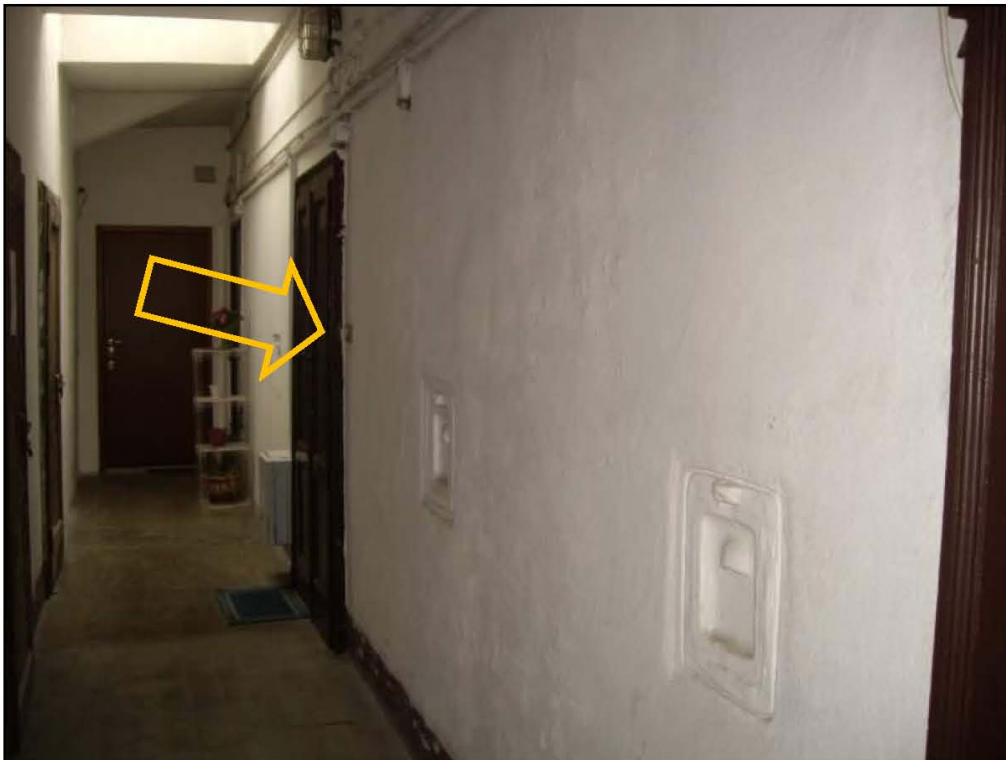
Pianerottolo comune e porta di ingresso
