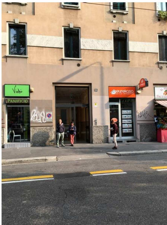
Ingresso al complesso residenziale – Viale Umbria n°66 – Milano – (MI)
