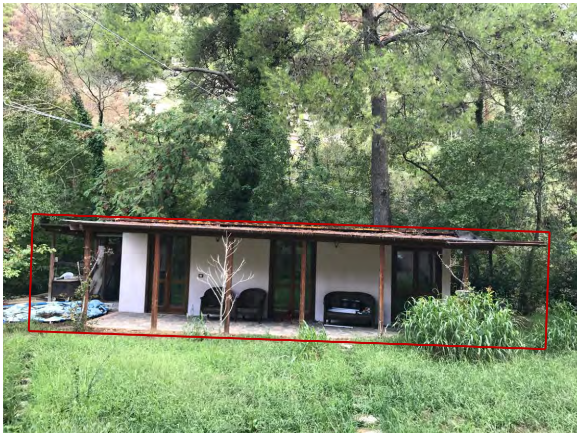
Foto n. 6: dépendance (evidenziata in rosso) realizzata abusivamente e che deve essere demolita.
