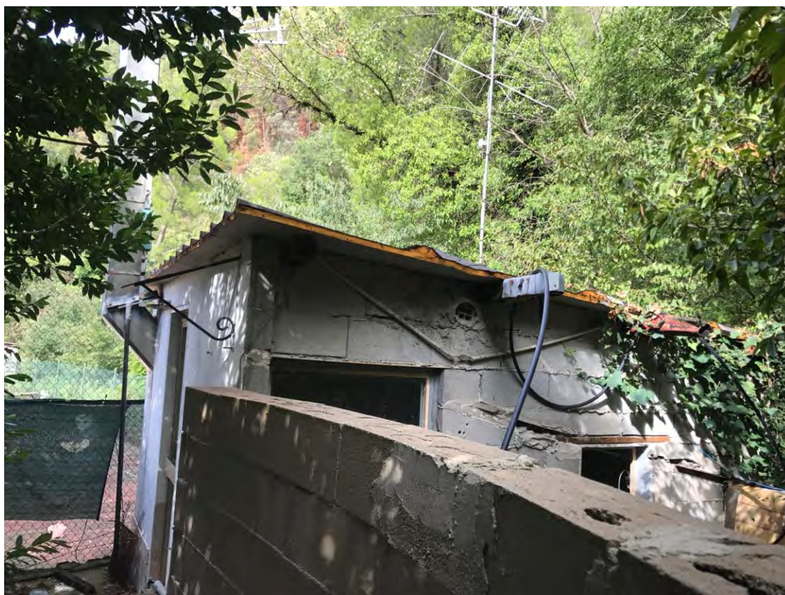
Foto n. 9: locale lavanderia come indicato nella concessione edilizia in sanatoria e sulla cui destra vi era il pollaio ora rimosso.
