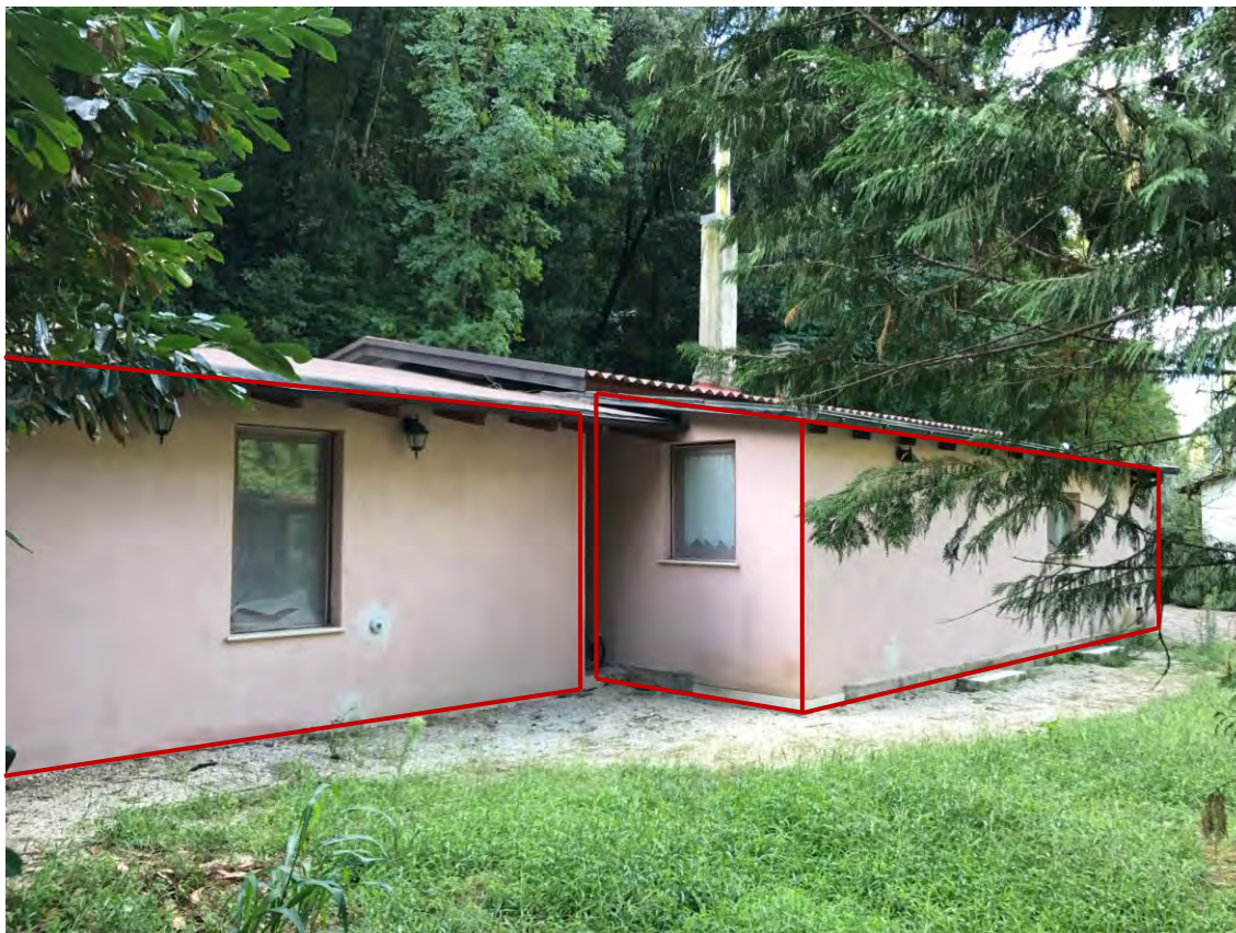
Foto n. 4: abitazione e corte esterna viste dal lato del torrente Serra. La porzione evidenziata in rosso, così come quella in primo piano sono alcune delle opera abusive realizzate e che devono essere demolite.
