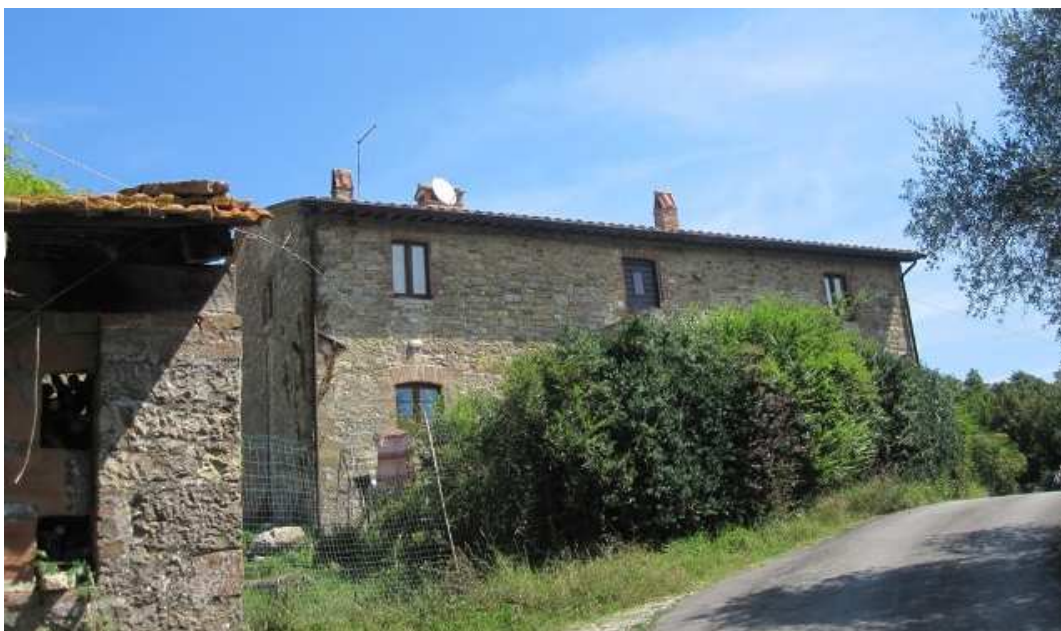
A/1)- VISTA SRADA COMUNALE "CERQUETO-LA SCARZUOLA-MONTEGIOVE" - LATO SUD
