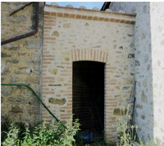
ACCESSORIO A/2) INGRESSO RETROSTANTE NORD
