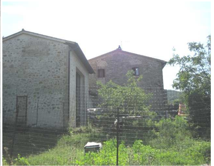
VISTE LATO NORD
