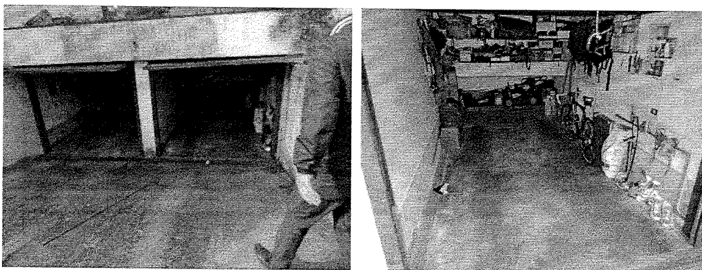
Rampa d'accesso e interno garage
