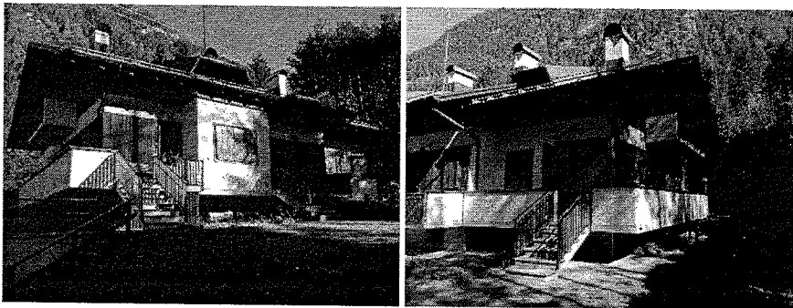
Fronte sud (accesso delle 3 unità del piano terra/rialzato)
