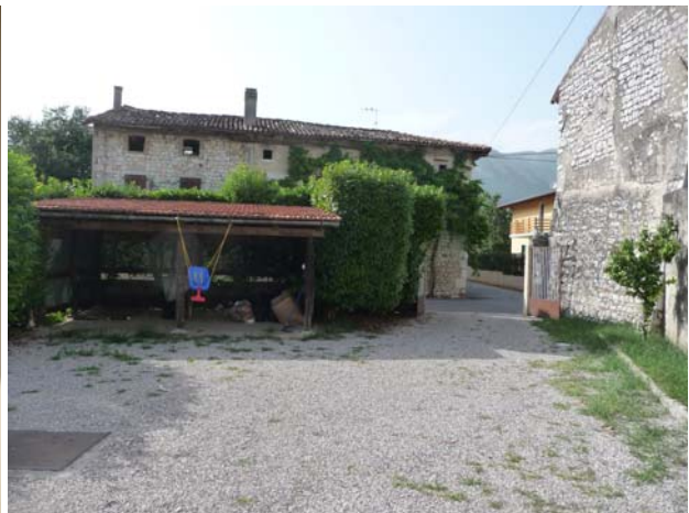
veduta tettoia - ingresso lotto
