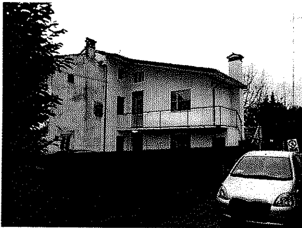
veduta lati nord-ovest e ovest
