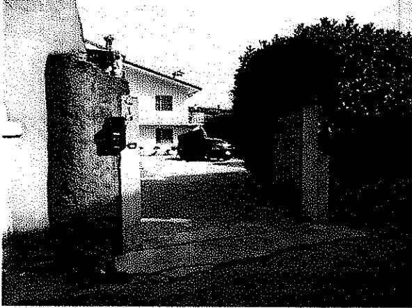
veduta ingresso carraio
