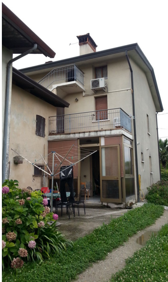
Foto n.5: Prospetto Sud ed Est dell'abitazione (Sub.1-2) oggetto di E.I.
