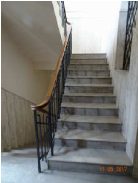
particolare vano scale (mappale 1026 sub. 25)
