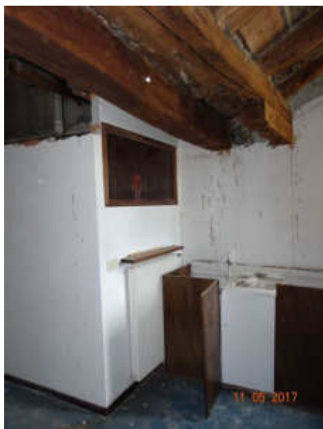
particolare zona ingresso bagno
