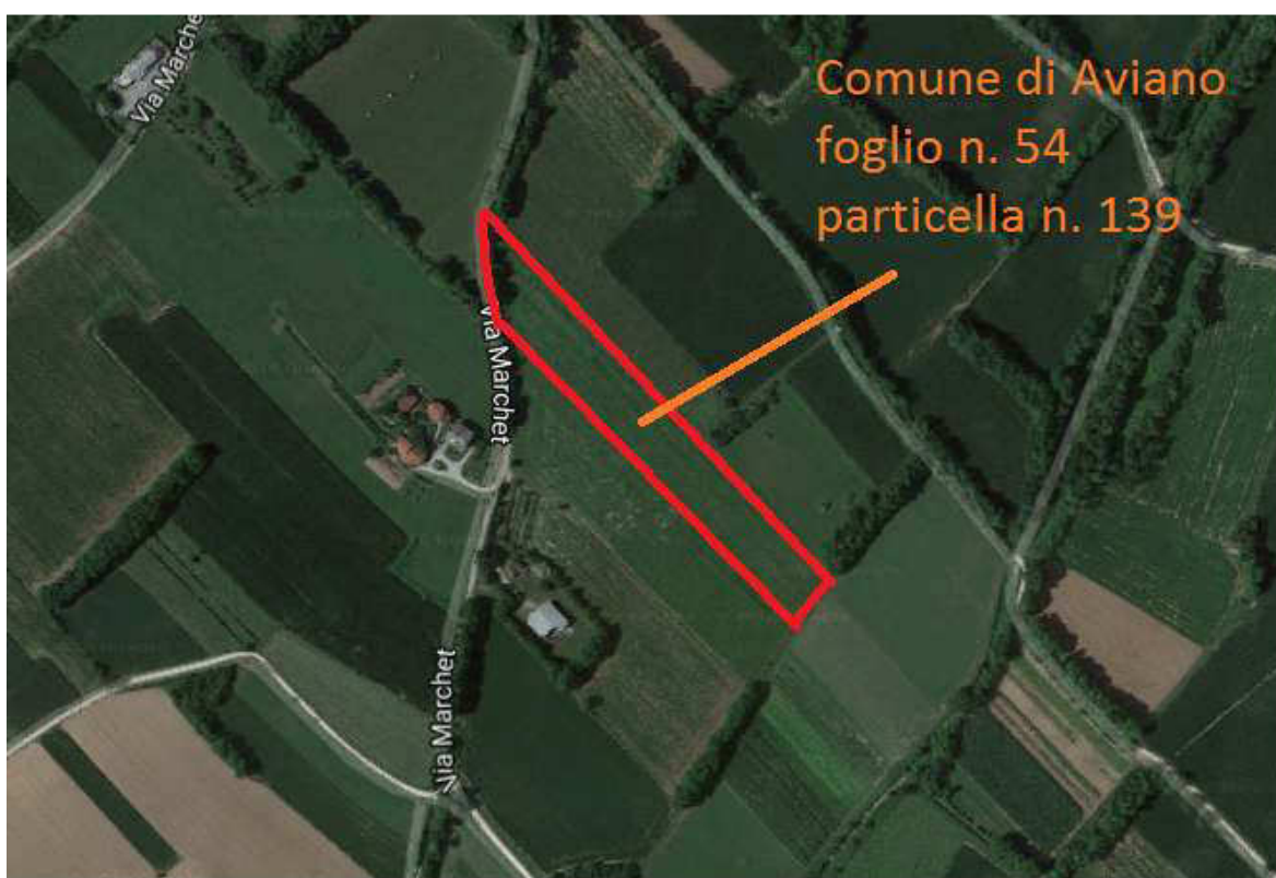
Foto n. II – Foto aerea del compendio esecutato – bordato in rosso (fonte google map).
