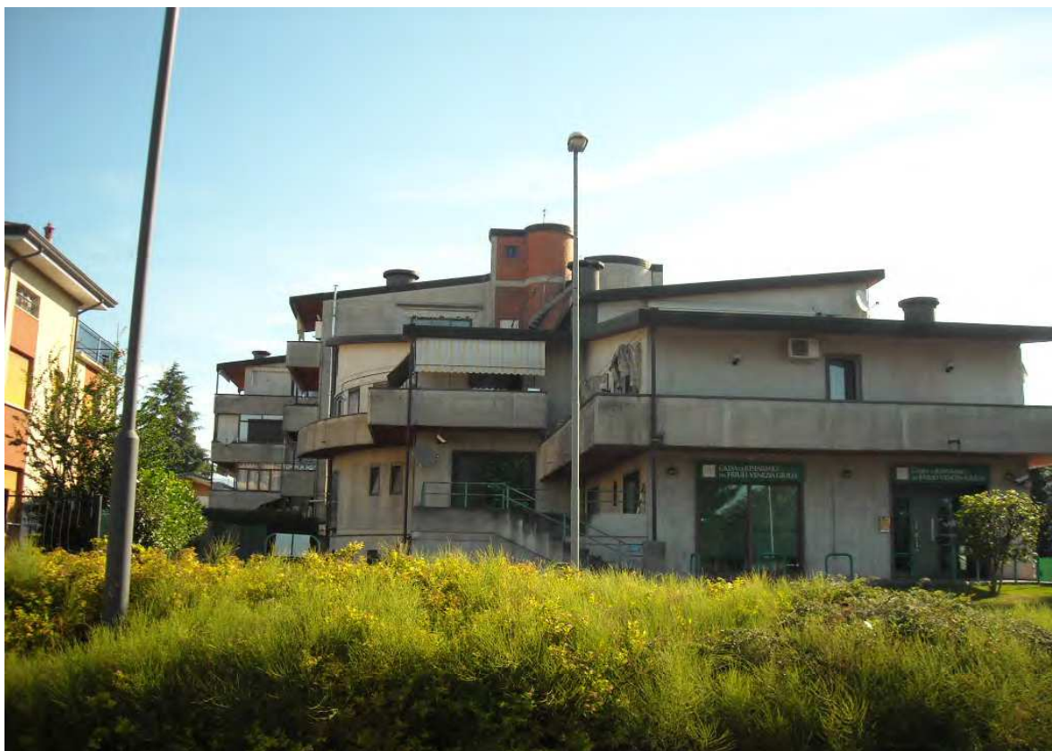
Foto 2 – vista sud-est dell'edificio da Via Pordenone lato Nord - Ovest
