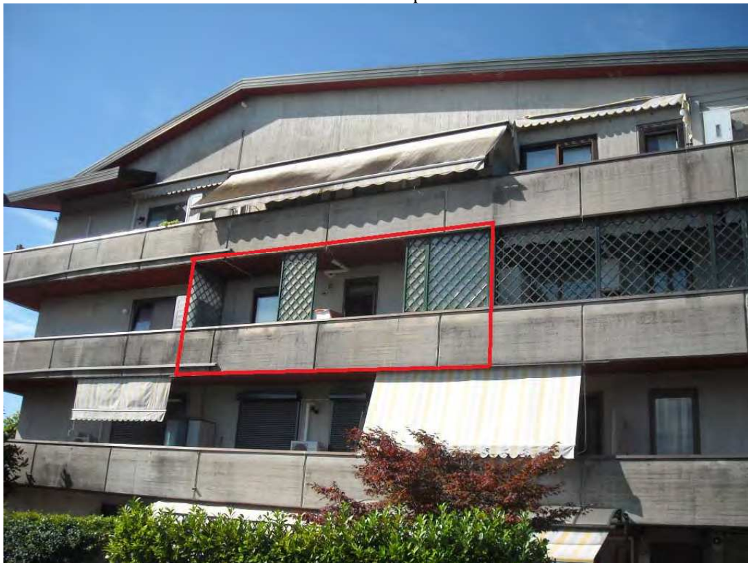
Foto 1 - lato nord-est con evidenziata la posizione dell'unità immobiliare
