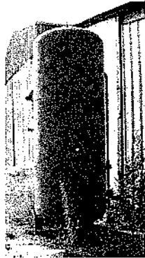
Serbatoio - Polmone capacità 6.000 l.
