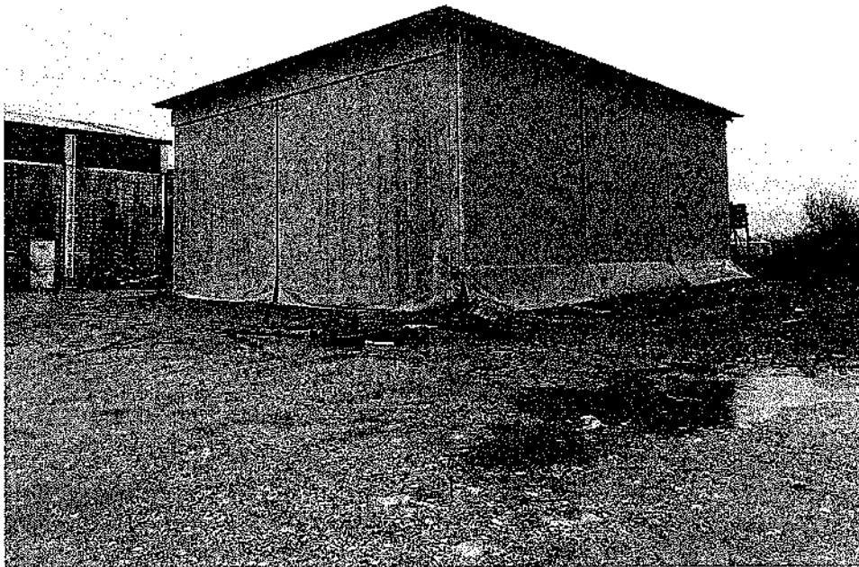
Tettoia per sabbiatura.
