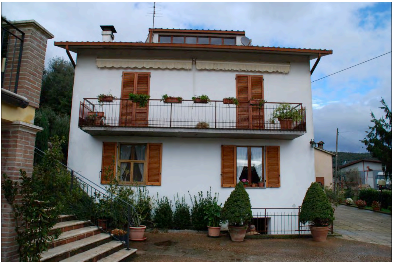
04_Foto del 12-11-2016_Abitazione Fg. 54 part. 61 sub. 2
