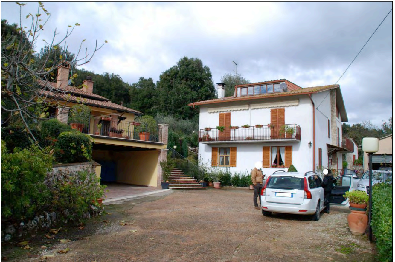
02_Foto del 12-11-2016_Abitazione Fg. 54 part. 61 sub. 2
