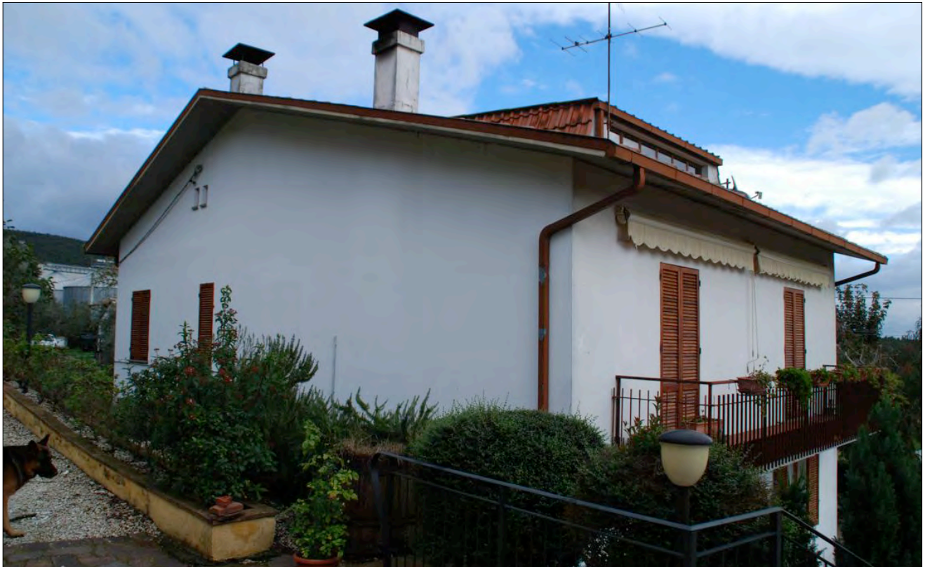
05_Foto del 12-11-2016_Abitazione Fg. 54 part. 61 sub. 2
