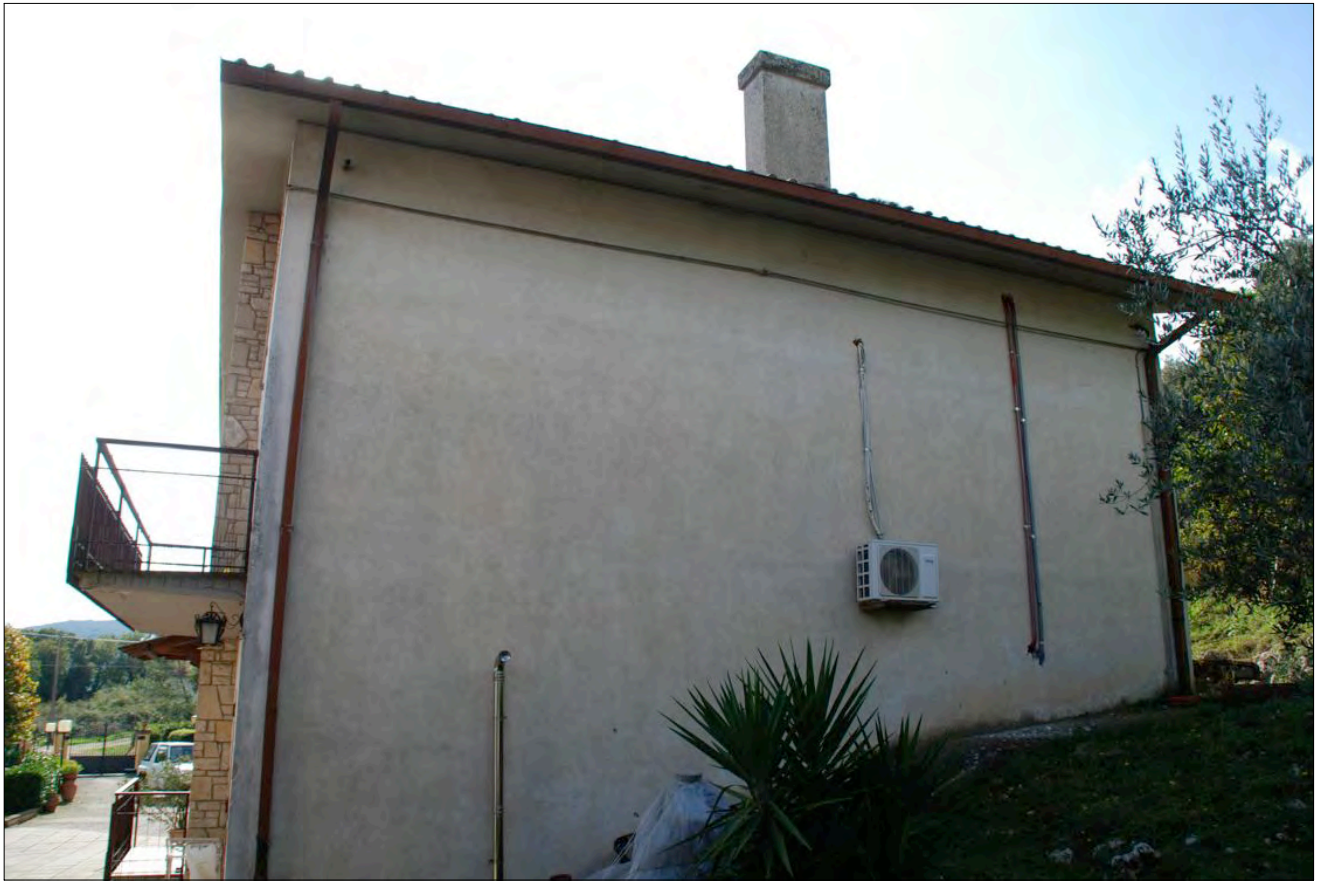
07_Foto del 03-11-2016_Abitazione Fg. 54 part. 61 sub. 2
