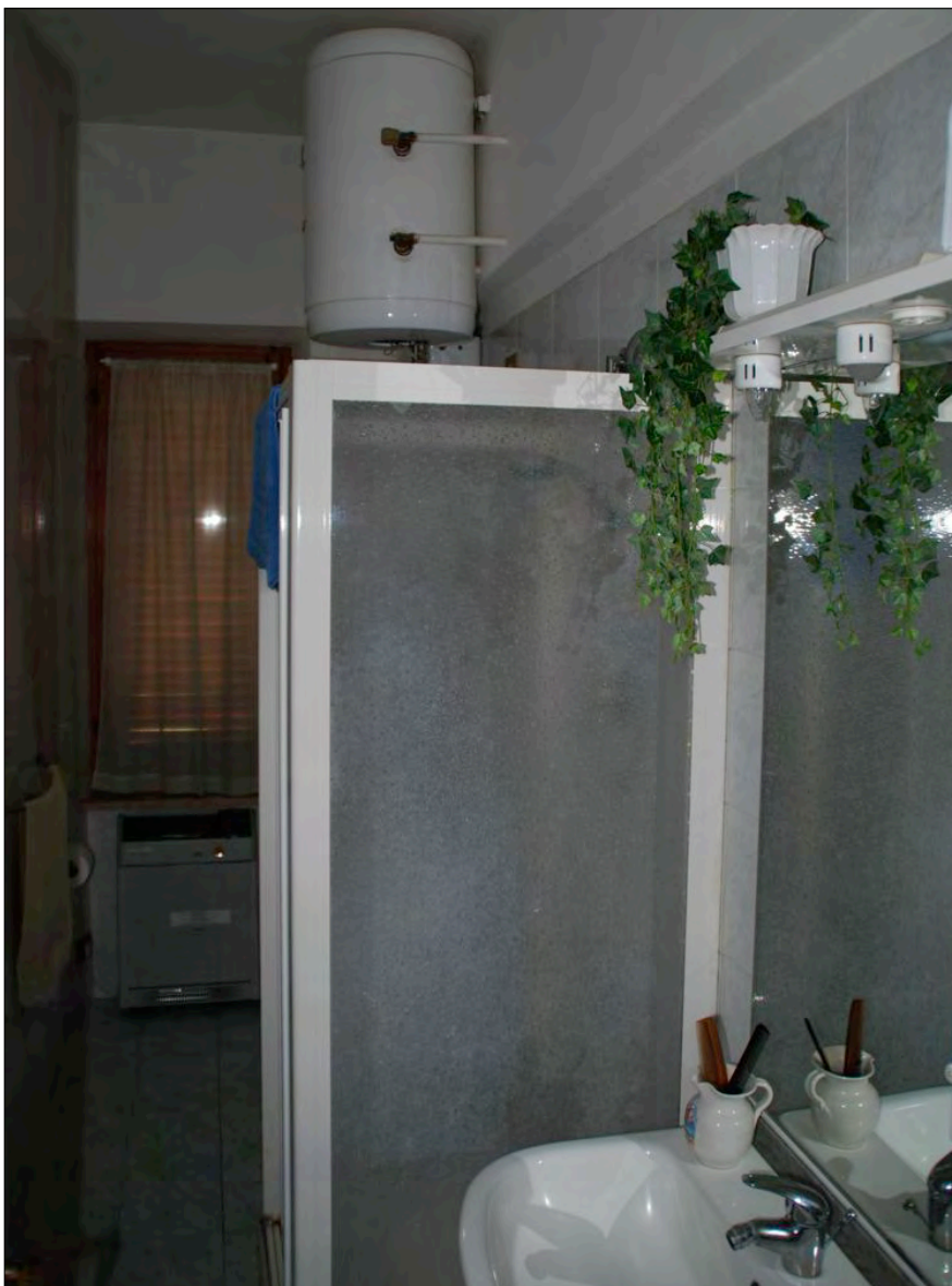
16_Foto del 12-11-2016 Abitazione Fig. 54 part. 61 sub. 2
