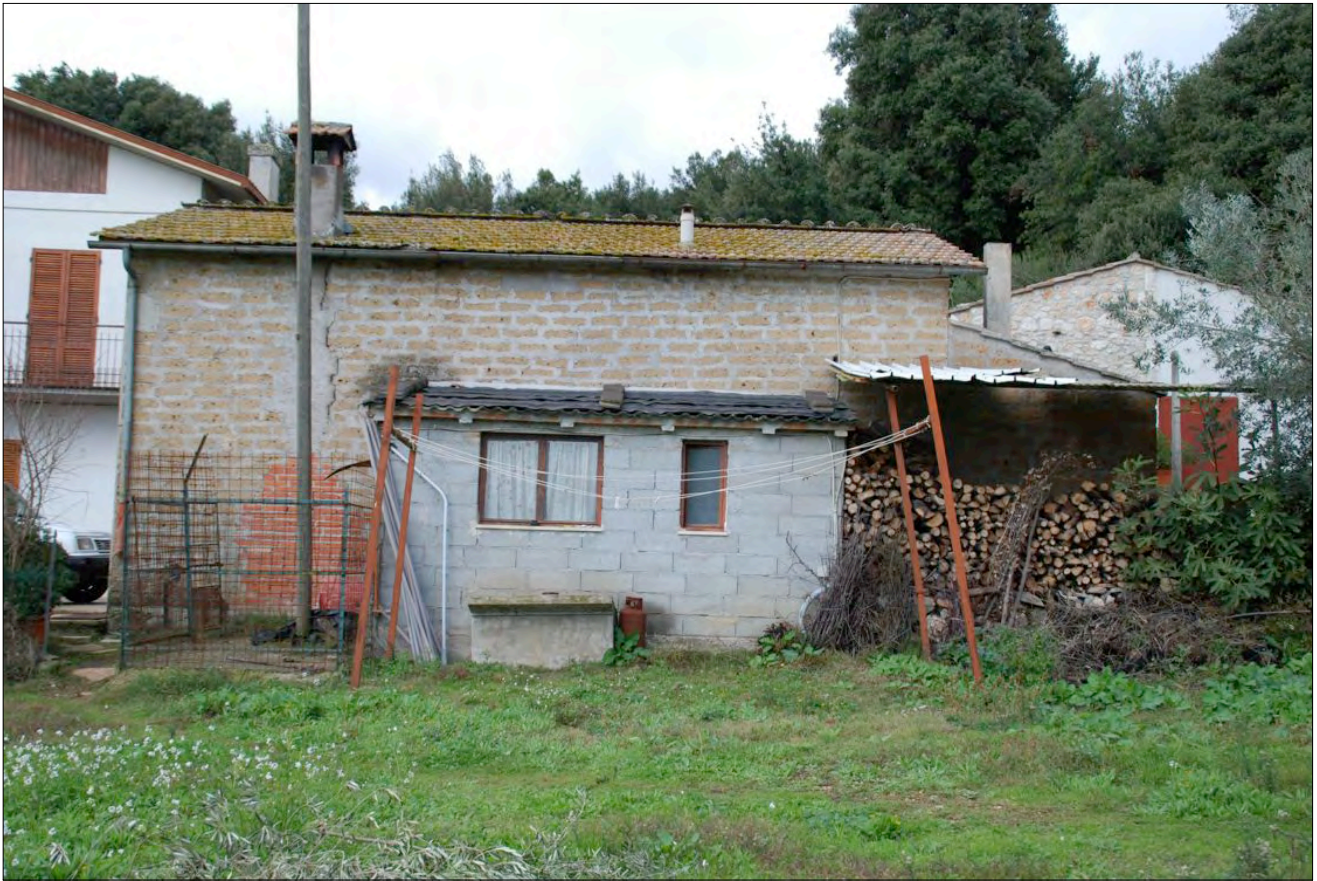
03_Foto del 12-11-2016_garage Fg. 54 part. 61 sub. 3
