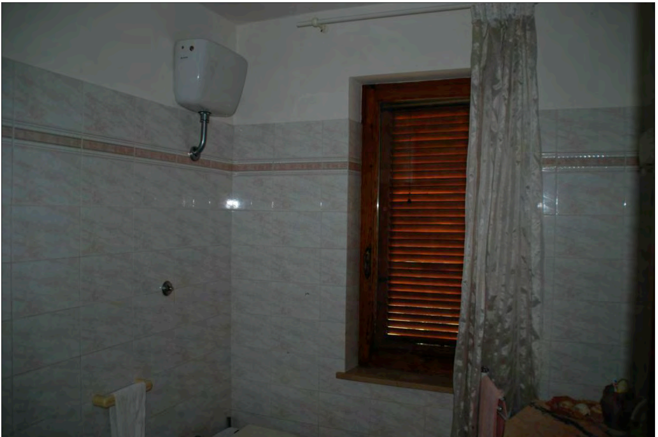
14_Foto del 03-11-2016_Interno Abitazione Fg. 54 part. 61 sub. 2
