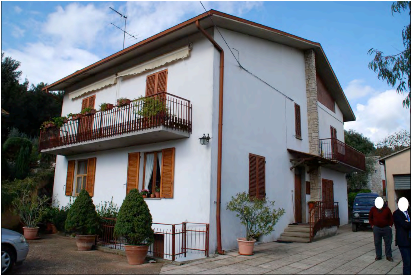
03_Foto del 12-11-2016_Abitazione Fg. 54 part. 61 sub. 2
