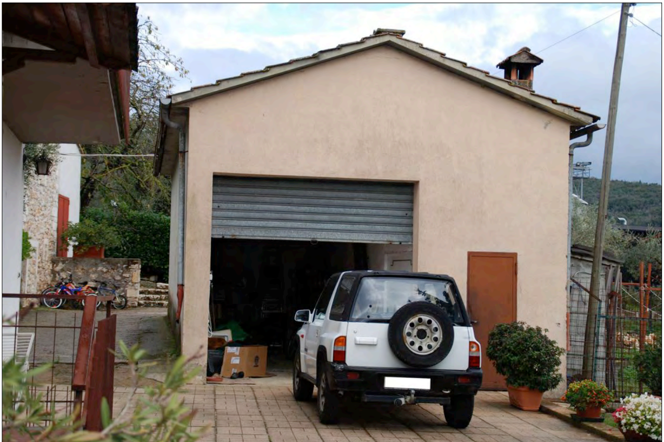
01_Foto del 12-11-2016_garage Fg. 54 part. 61 sub. 3
