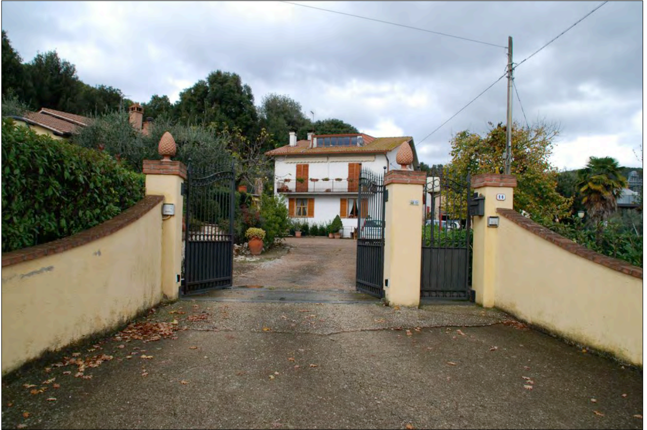
01_Foto del 12-11-2016_Abitazione Fg. 54 part. 61 sub. 2
