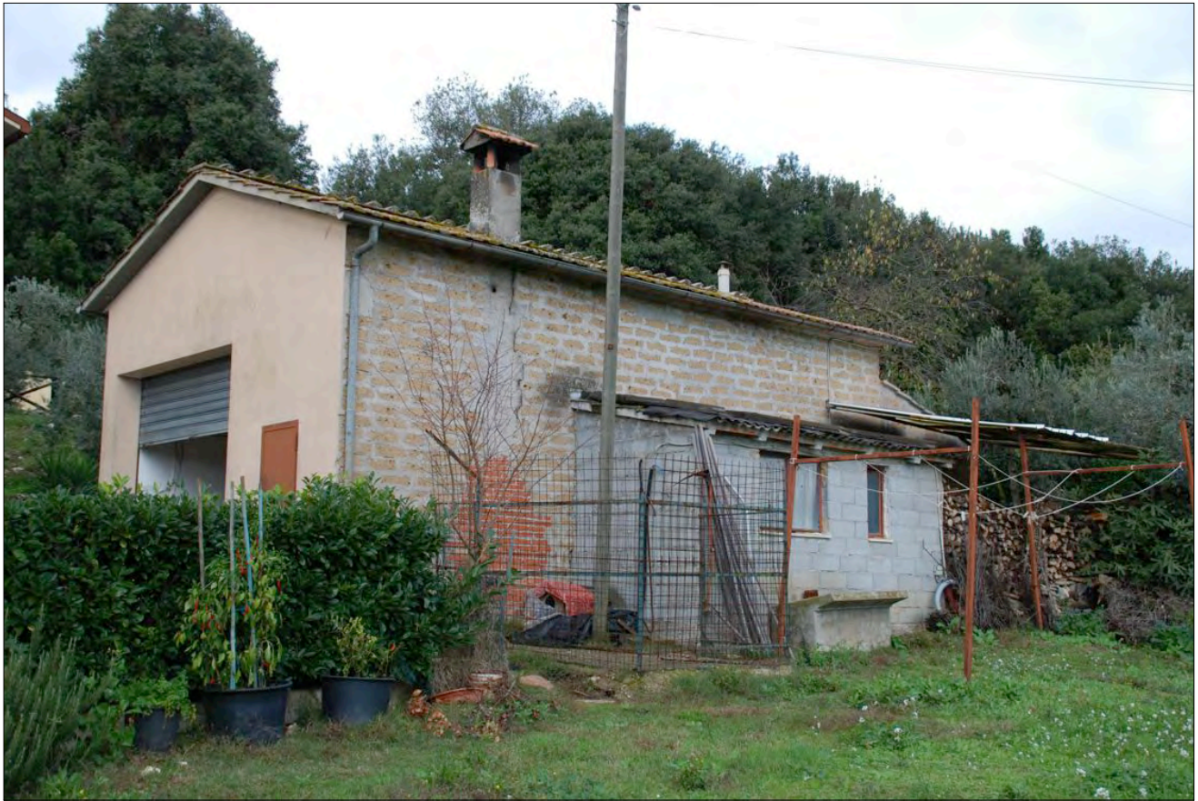
02_Foto del 12-11-2016_garage Fg. 54 part. 61 sub. 3
