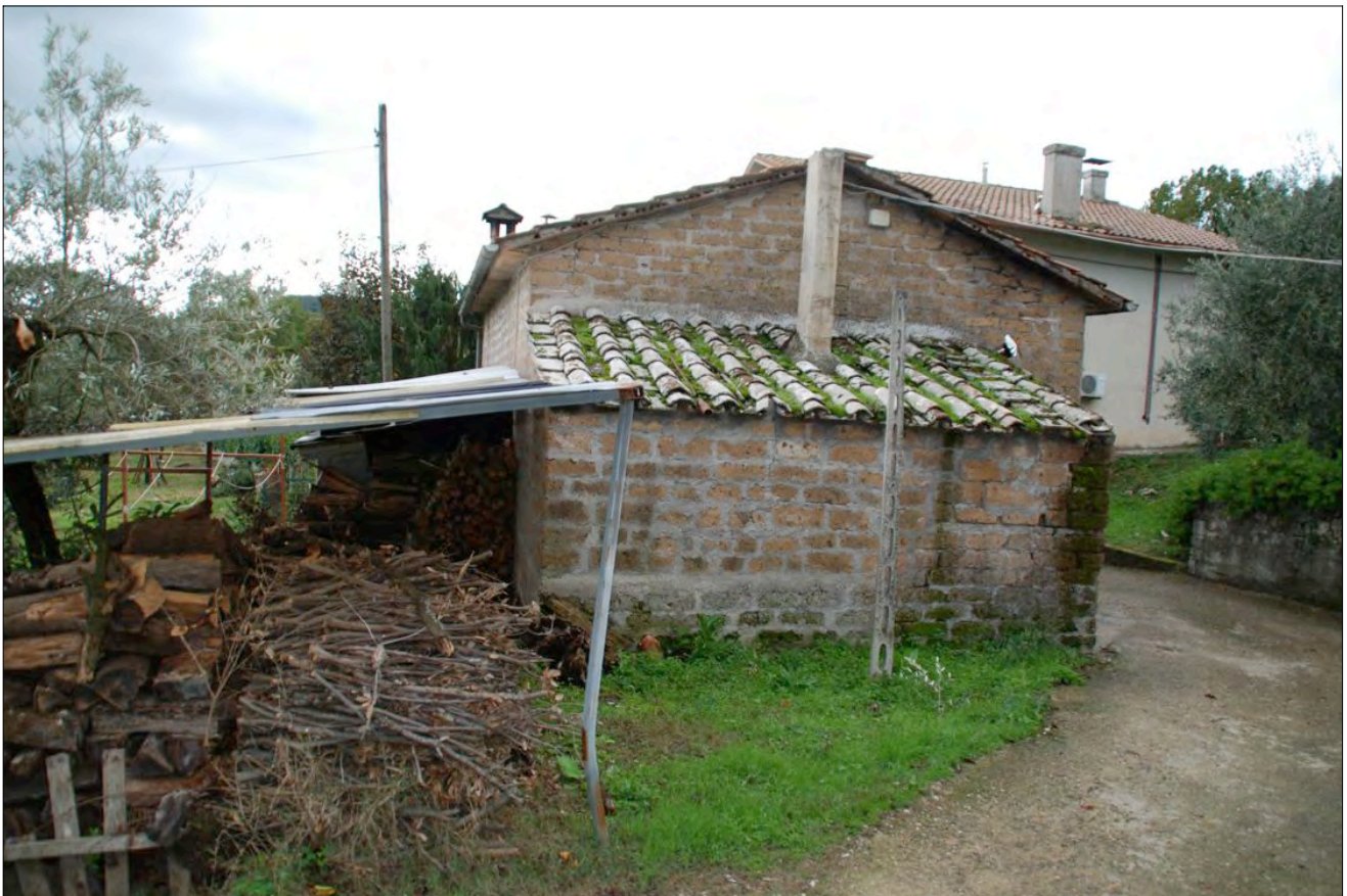
02_Foto del 12-11-2016_garage Fg. 54 part. 61 sub. 3
