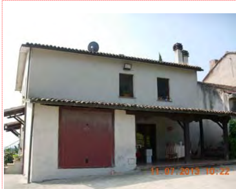
- cantina e portico sul prospetto nord – ovest -
