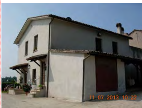
- ingresso della u.i. al primo piano -
