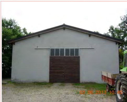
- prospetto principale sul fronte dell'ingresso -
