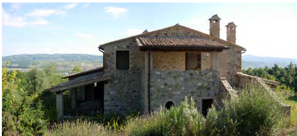
- fabbricato in corso di ristrutturazione, in località Podere Ferriere, 9 -
