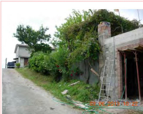
- strada di accesso dalla strada vicinale -
