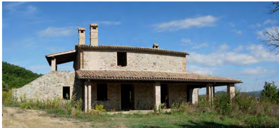
- fabbricato in corso di ristrutturazione, in località Podere Ferriere, 9 -
