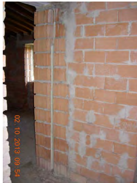
- giunto tra le appendici sul fronte posteriore -
