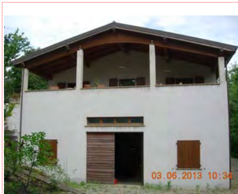
- prospetto sul fronte posteriore -
