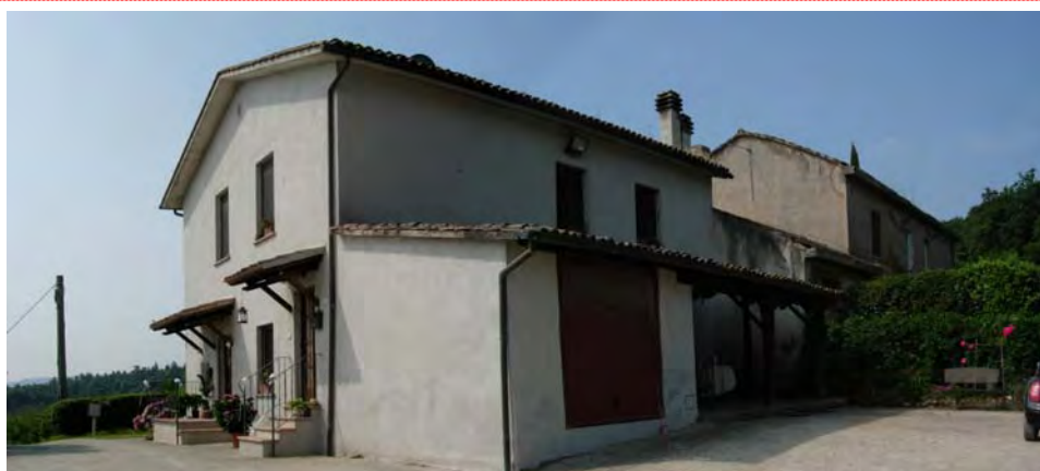
- panoramica del fabbricato residenziale, ripresa dalla corte comune -
