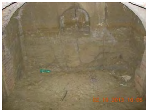
- cantina al piano interrato -
