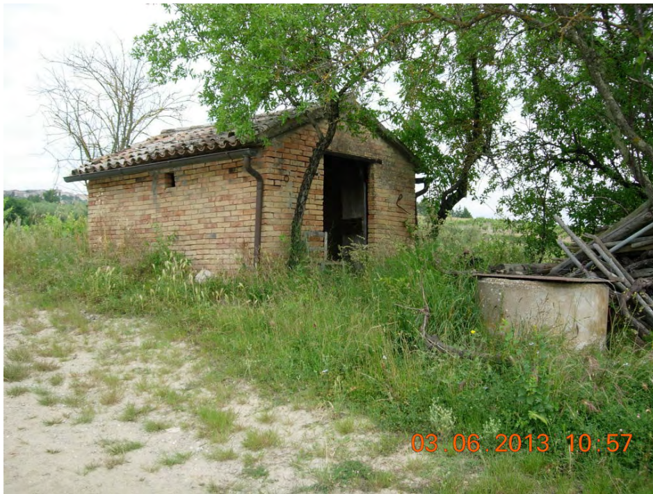
- Edificio accessorio in vocabolo "Gineprete" (D) -
