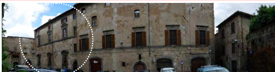
- Prospetto del Palazzo Benincasa su Piazza Clementini -
