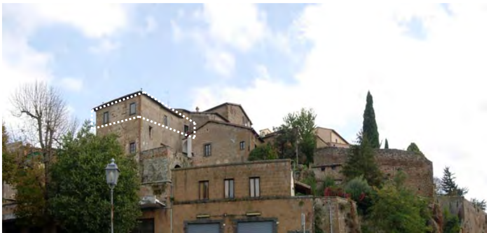
- affaccio dell'unità immobiliare sul versante di Porta Romana -
