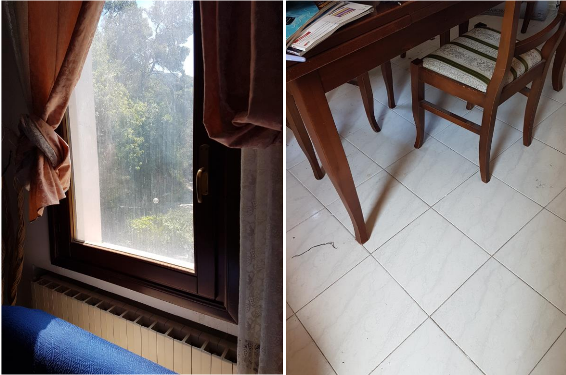
Particolari finestre nuove (legno), calorifero (ghisa, moderno) e pavimenti recenti
