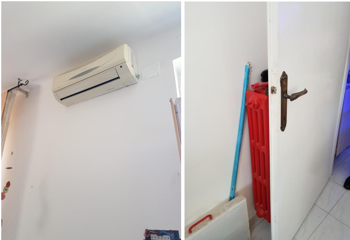
Unico condizionatore; dettagli infissi interni e caloriferi (qui ghisa)
