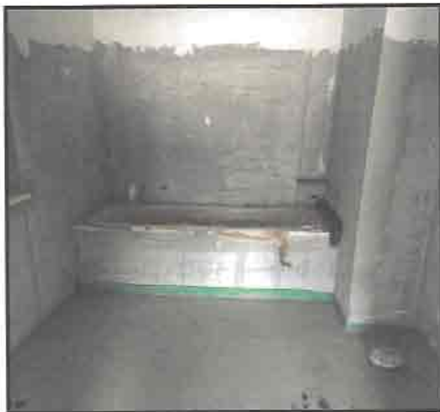
Figura 40: particolare secondo bagno nel piano primo dell'immobile
