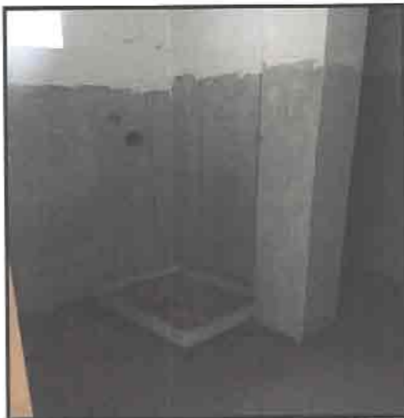
Figura 17: particolare al piano interrato.
