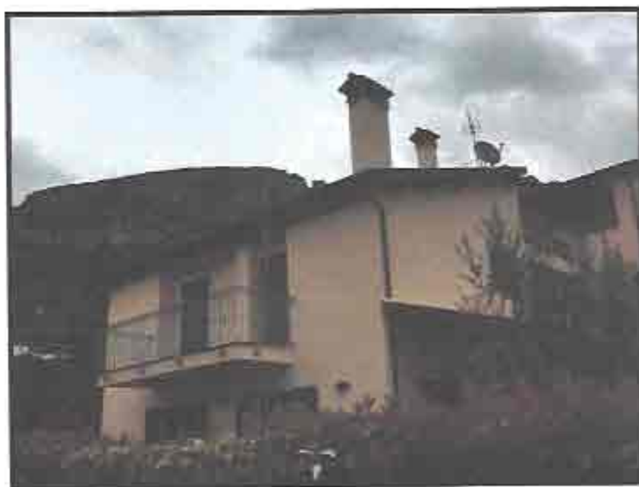
Figura 2 particolare prospetto laterale appartamento piano primo.
