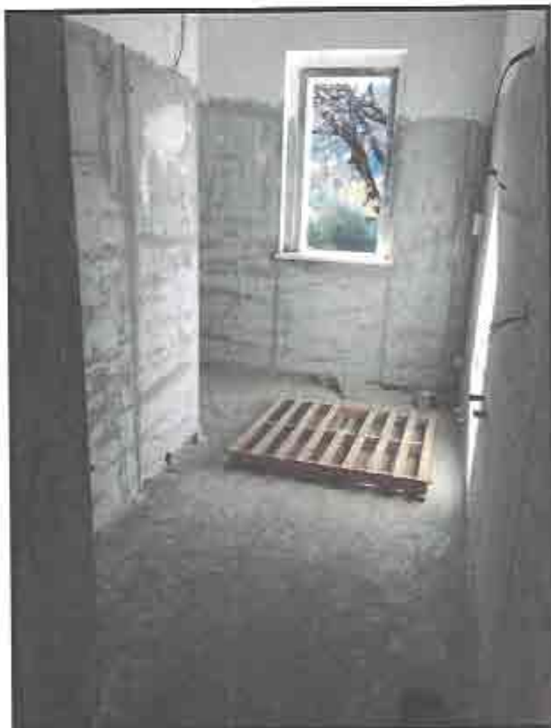
Figura 16: particolare bagno piano primo
