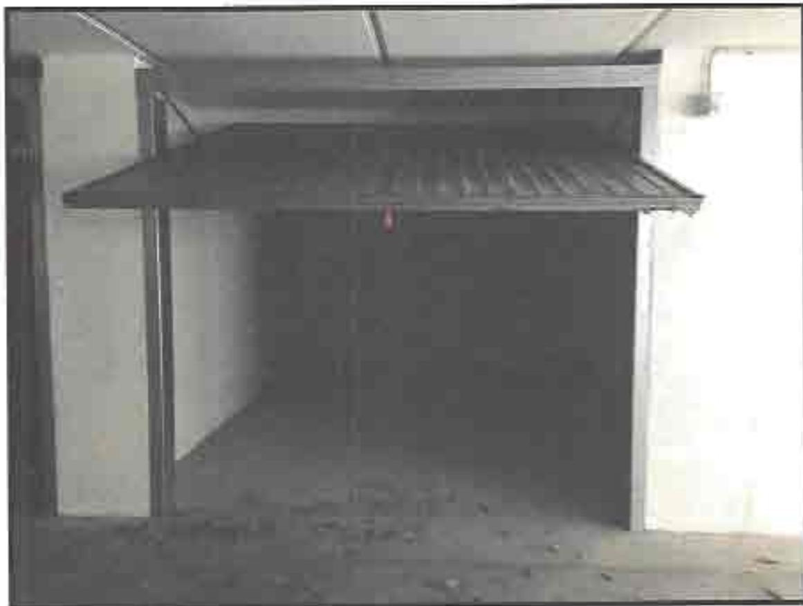
Figura 3 particolare ingresso garage.
