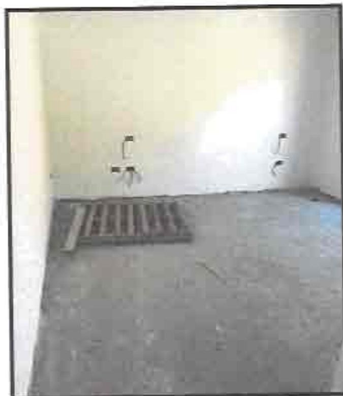
Figura 17: particolare della camera.
