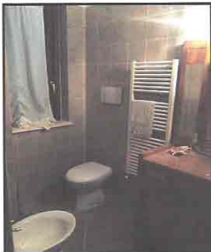
Figura 20: particolare del bagno al piano terra dell'immobile.
