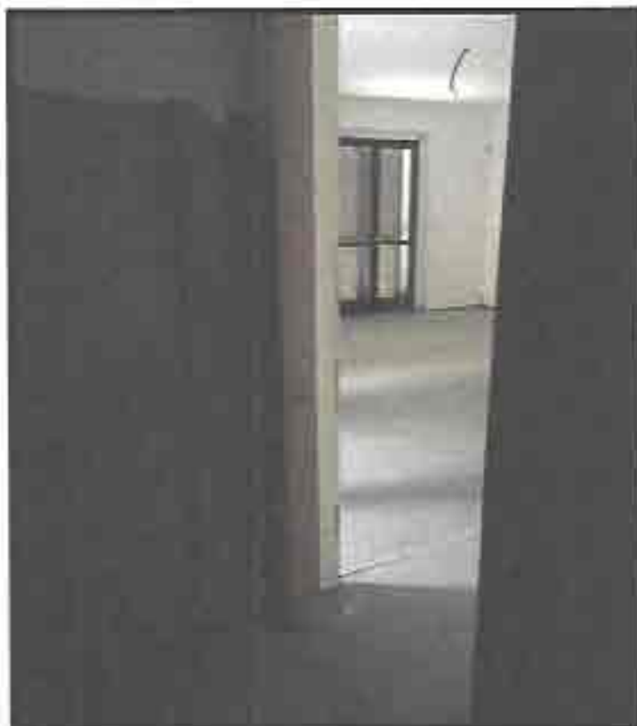
Figura 25: particolare bagno al piano terra.
