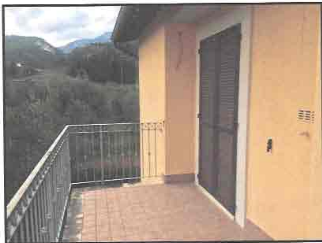
Figura 6: particolare balcone esterno.
