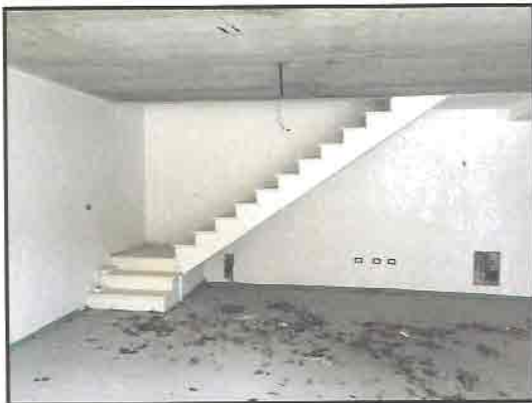
Figura 18: scale che collegano il piano terra al piano seminterrato.
