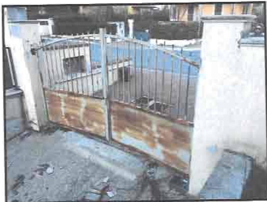
Figura 3 : Particolare del cancello di accesso all'abitazione.
