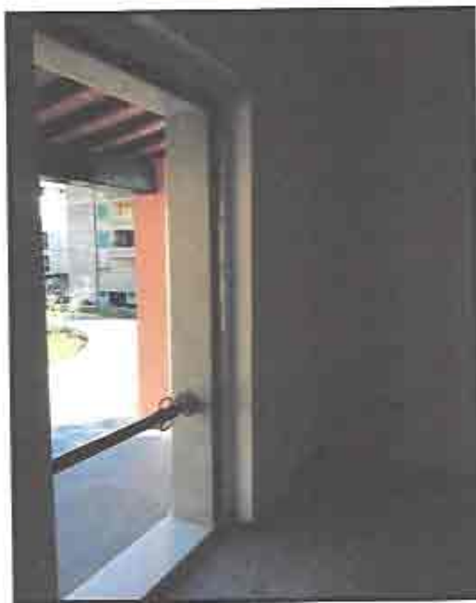
Figura 23: particolare finestra (accesso balcone).
