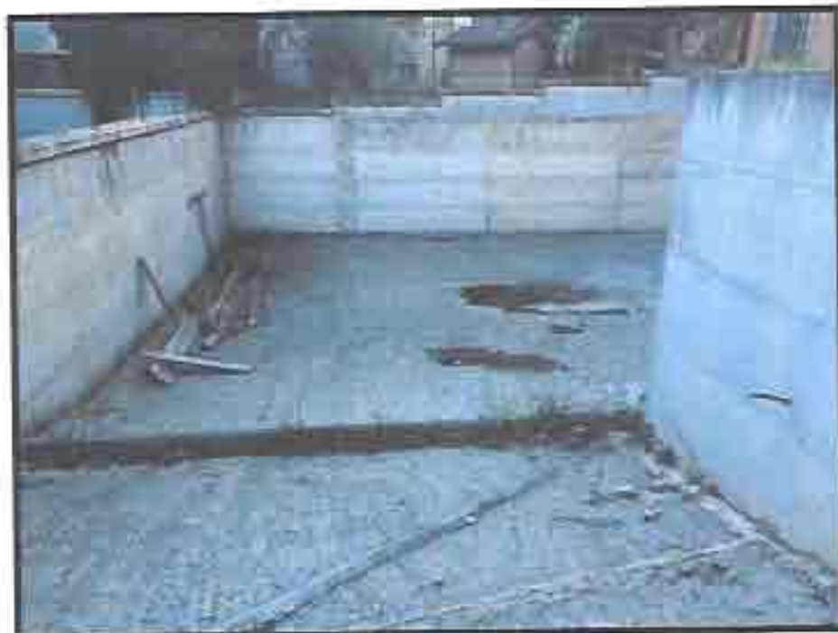
Figura 7: rampa di accesso al piano seminterrato.
