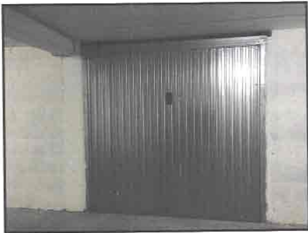
Figura 1: ingresso porta garage.
