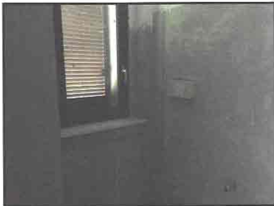
Figura 27: particolare bagno al piano terra.
