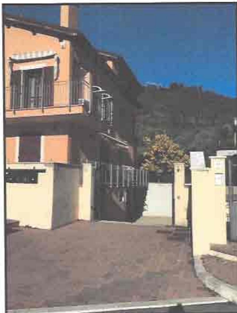
Figura 1: particolare ingresso rampa garage.
