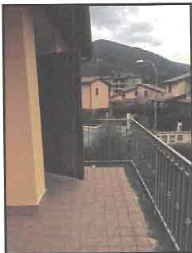
Figura 17: particolare balcone esterno.
