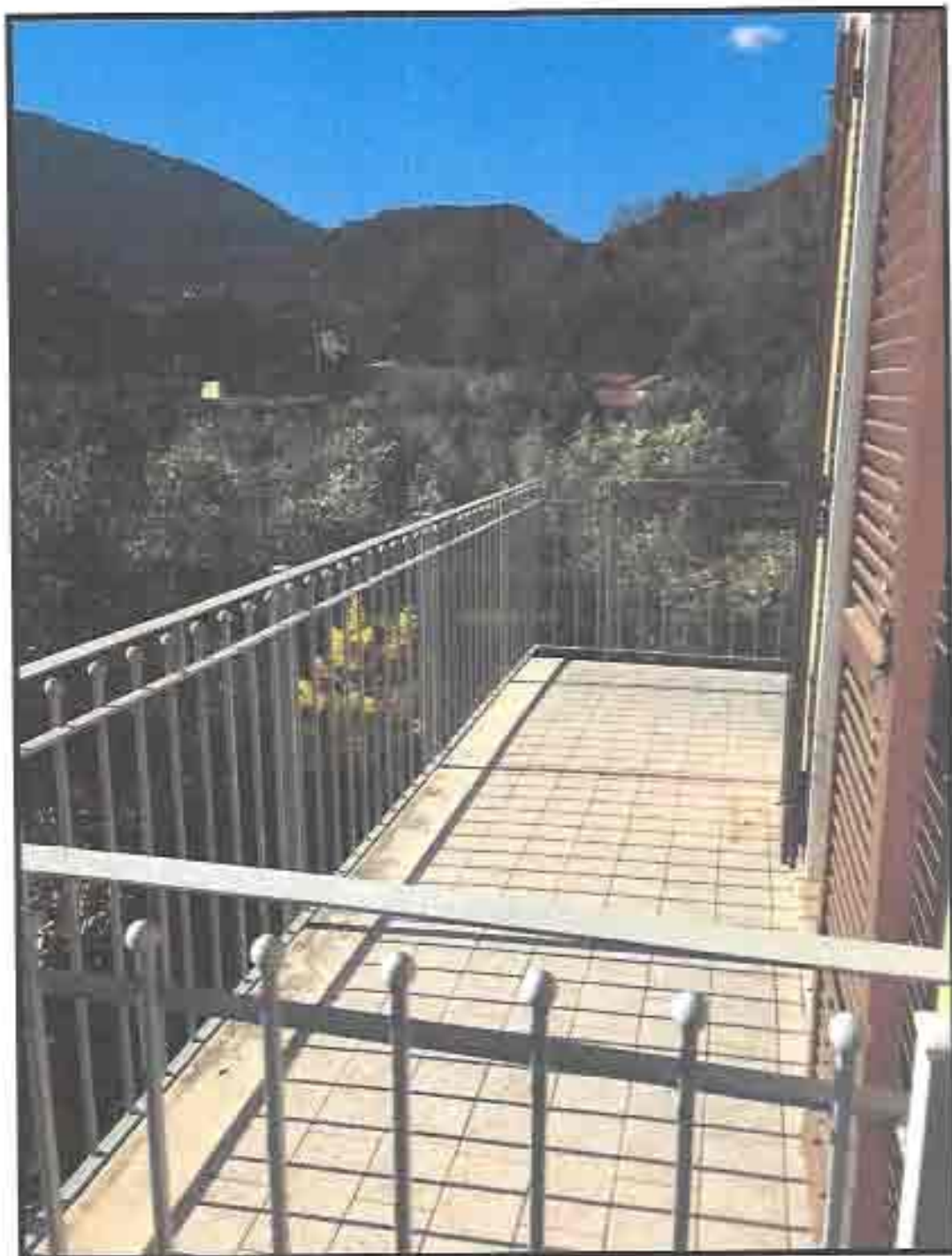
Figura 12: particolare balcone esterno.
