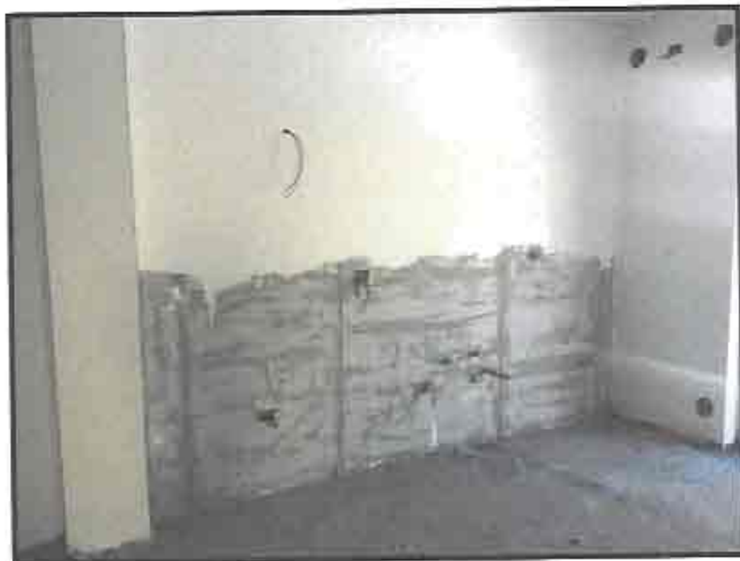
Figura 13: particolare angolo cottura al piano terra.
