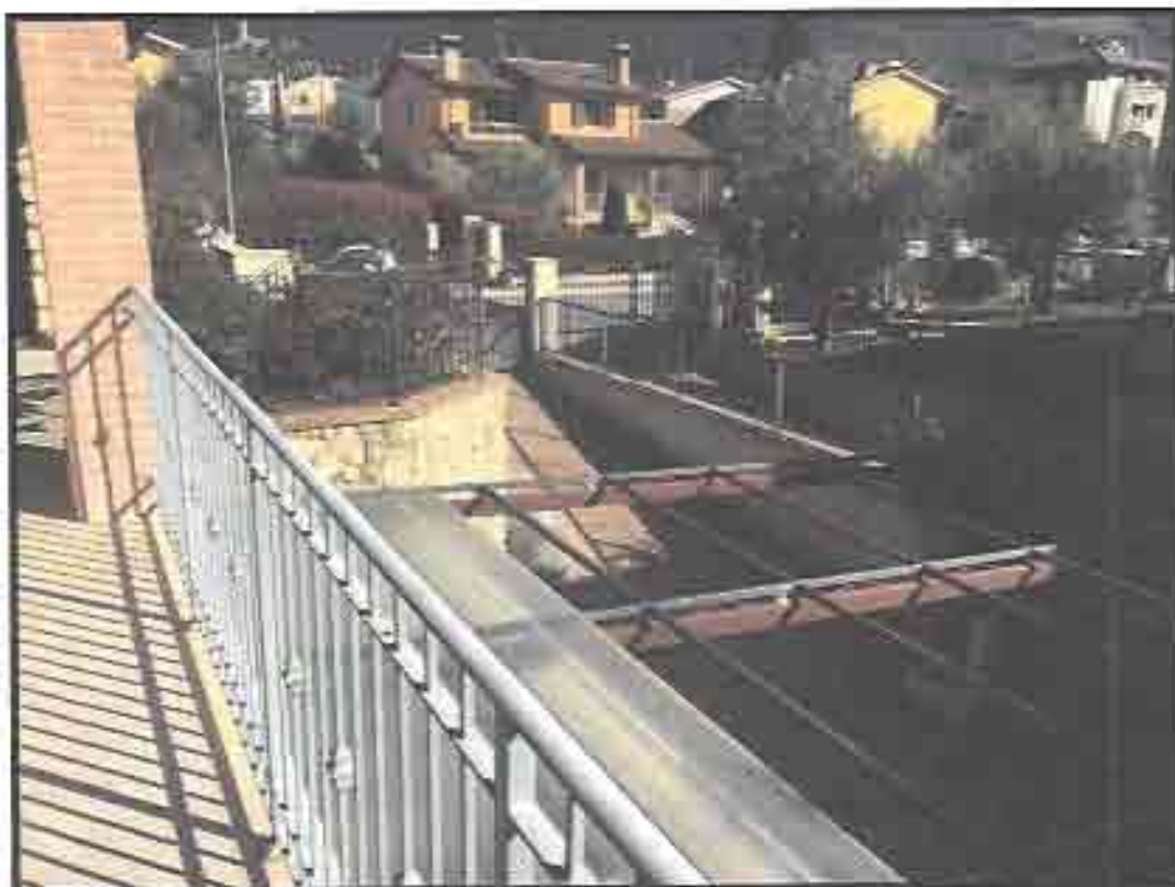
Figura 8: particolare vista verso la rampa di accesso al piano interrato dell'immobile.
