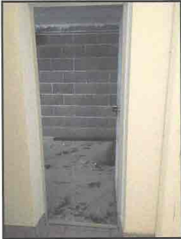
Figura 8: ingresso porta garage.
