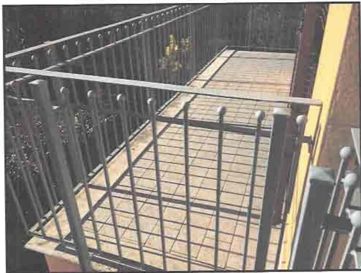
Figura 20: particolare balcone esterno.
