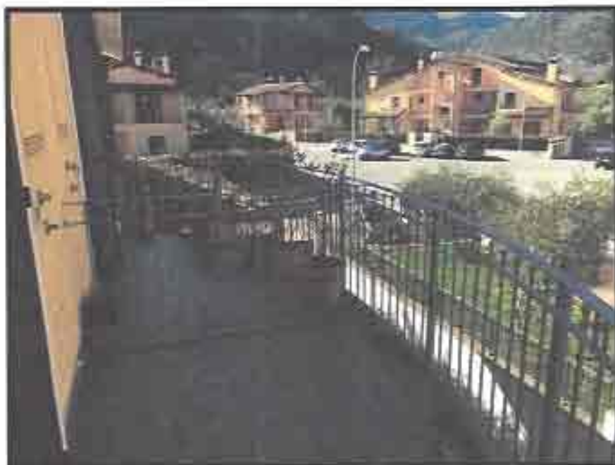
Figura 4: balcone dell'appartamento oggetto di perizia.
