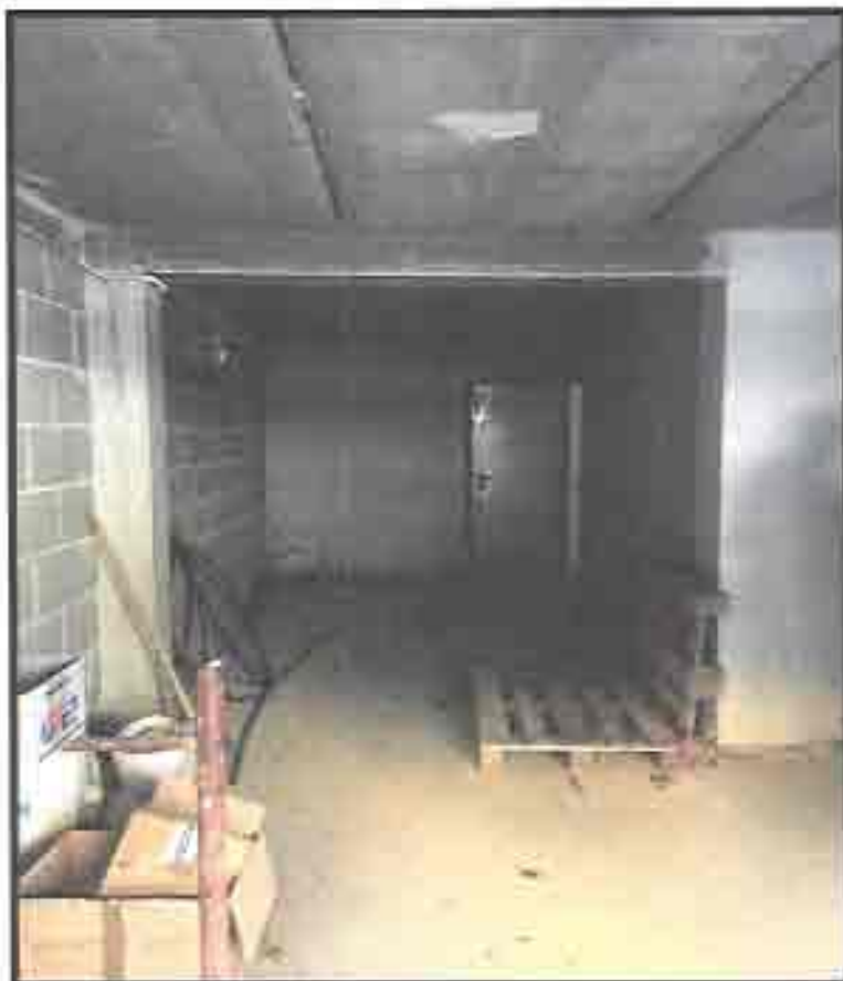
Figura 4: particolare interno garage.
