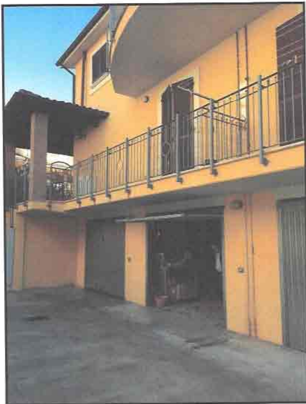
Figura 3: particolare ingresso al garage oggetto di perizia.
