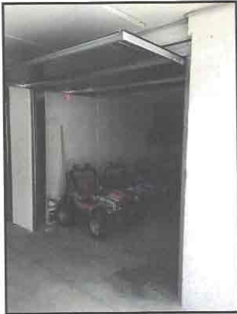
Figura 3: particolare ingresso garage.
