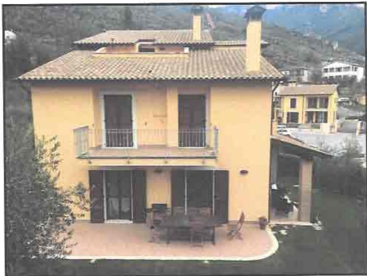
Figura 19: particolare veduta esterna appartamento piano primo.
