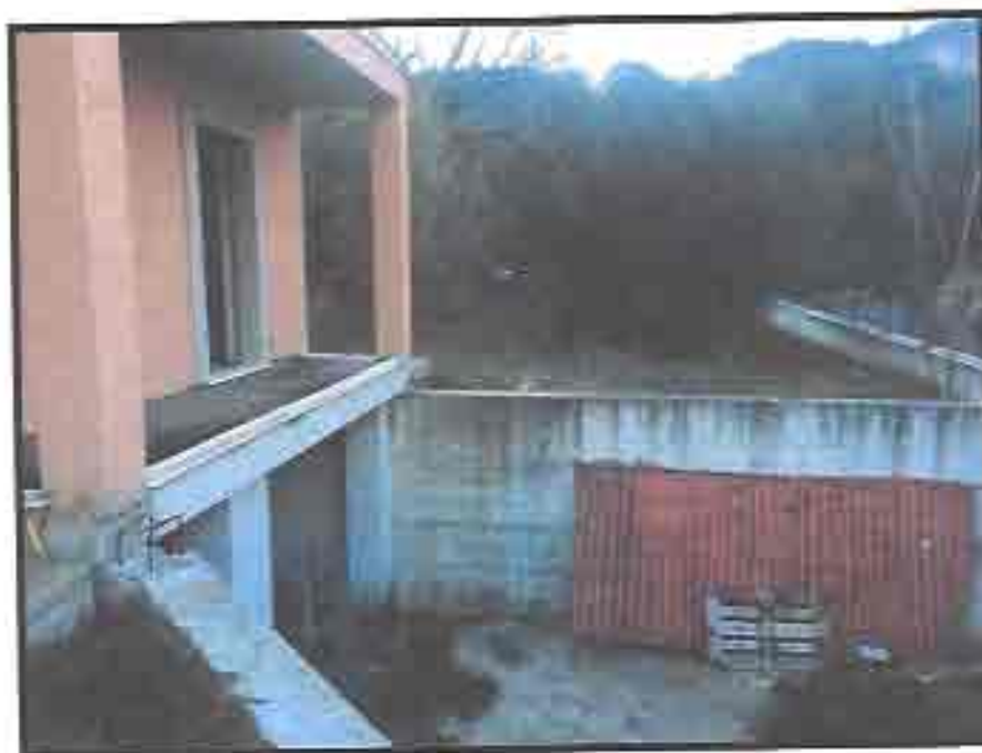
Figura 6: Particolare del piano interrato (ingresso garage tramite rampa) dell'immobile.
