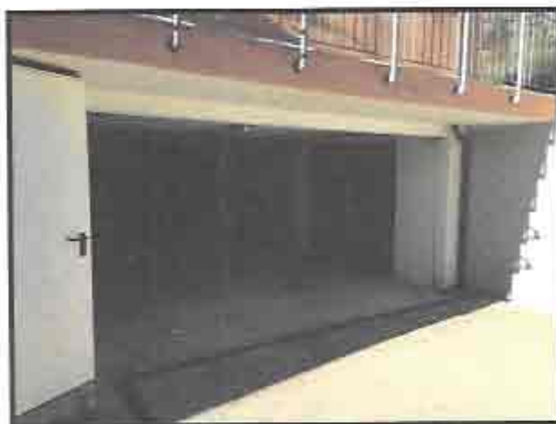
Figura 2: particolare ingresso garage.
