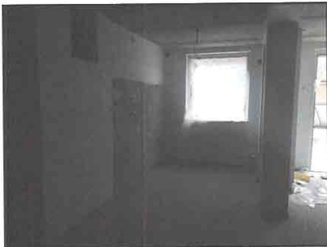
Figura 13: particolare interno al piano interrato dell'immobile.
