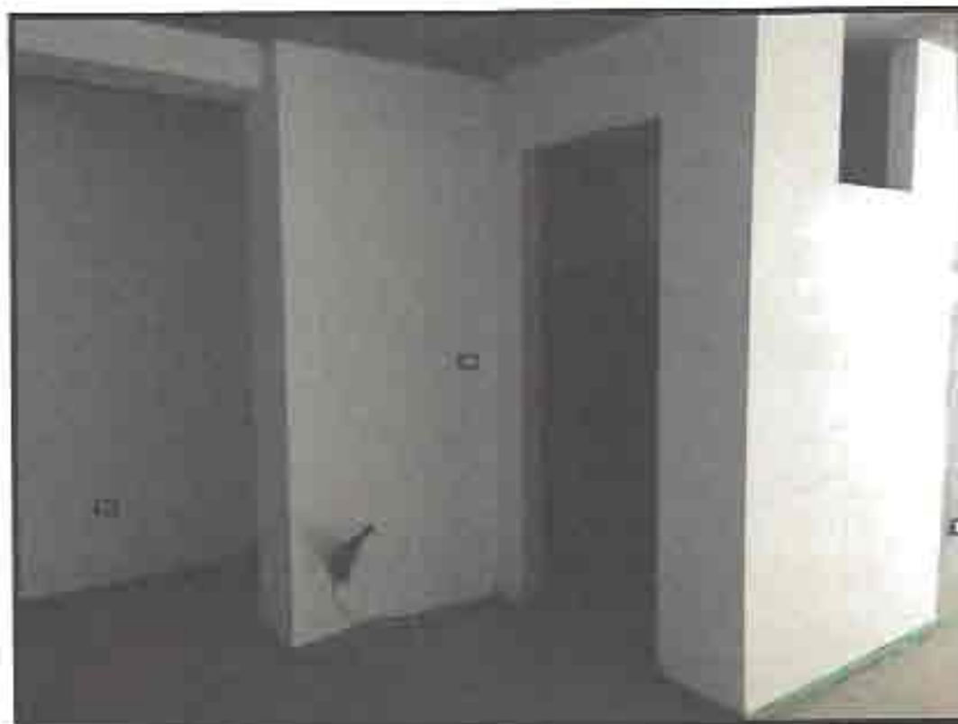
Figura 14: particolare piano interrato.
