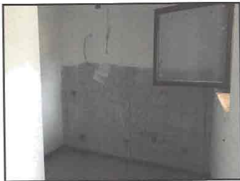
Figura 16 particolare del bagno.
