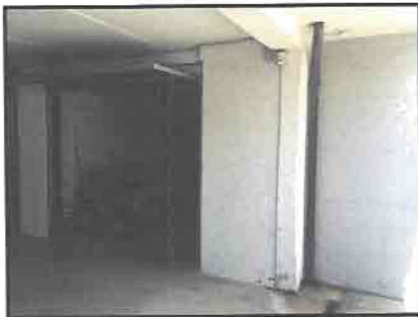
Figura 4: particolare ingresso garage.
