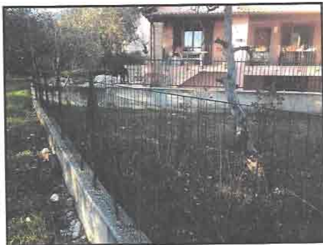
Figura 24: particolare della corte esterna di proprietà posta nel lato posteriore all'appartamento.
