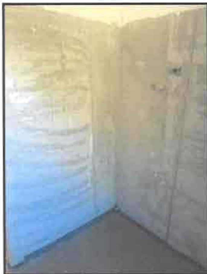
Figura 11 particolare pareti del bagno.
