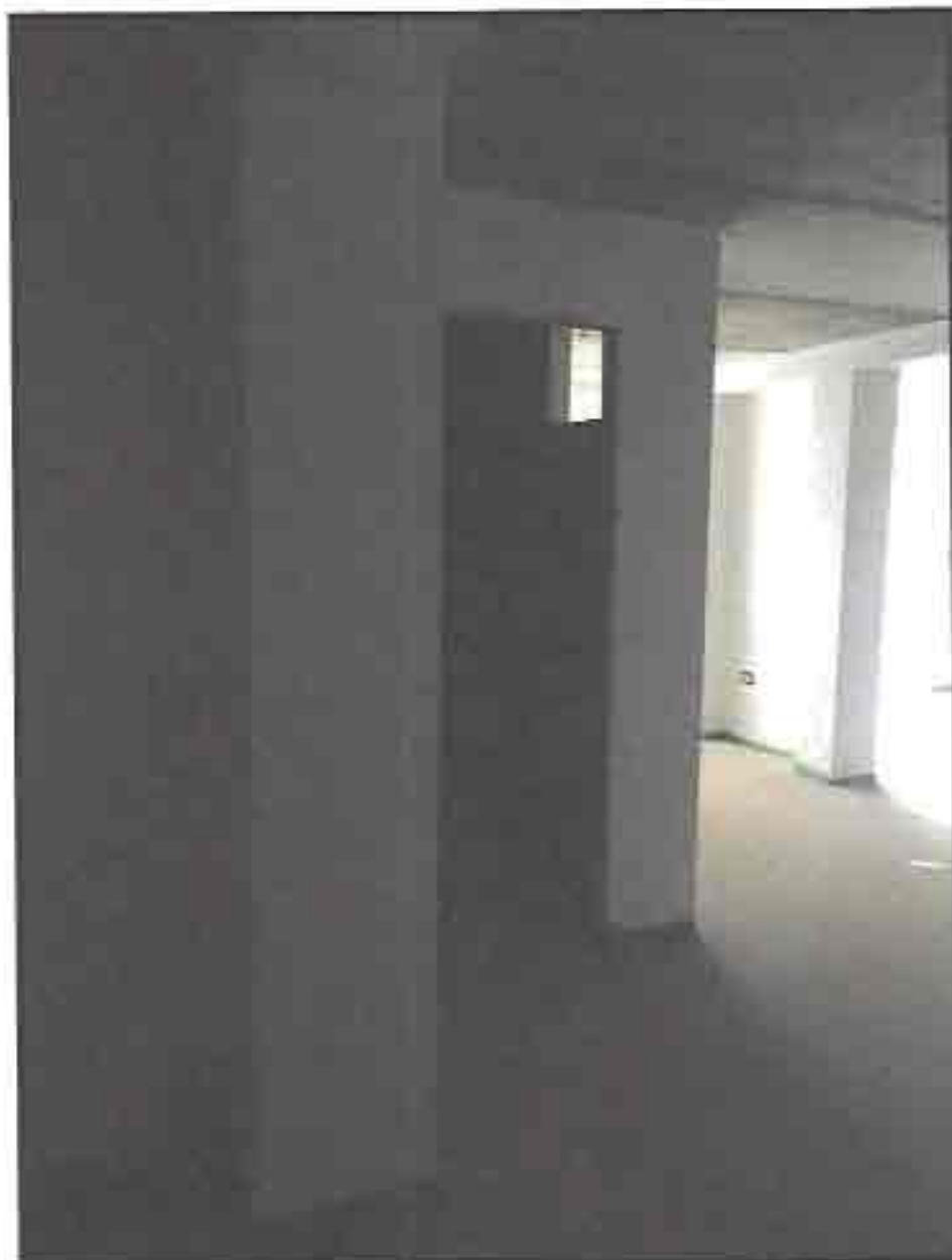
Figura 15: particolare interno dell'immobile al piano seminterrato.
