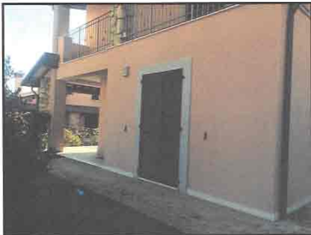
Figura 3: particolare prospetto laterale all'abitazione
