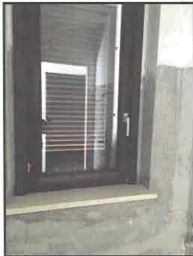
Figura 10: particolare finestra del bagno.
