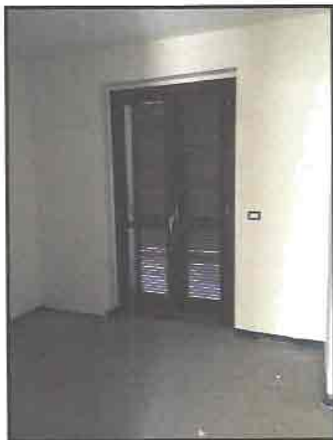
Figura 16 particolare prospetto della serranda camera.
