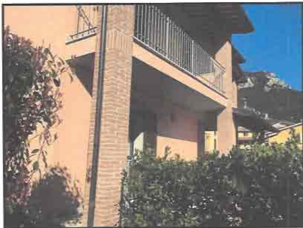
Figura 6: particolare prospetto laterale all'abitazione
