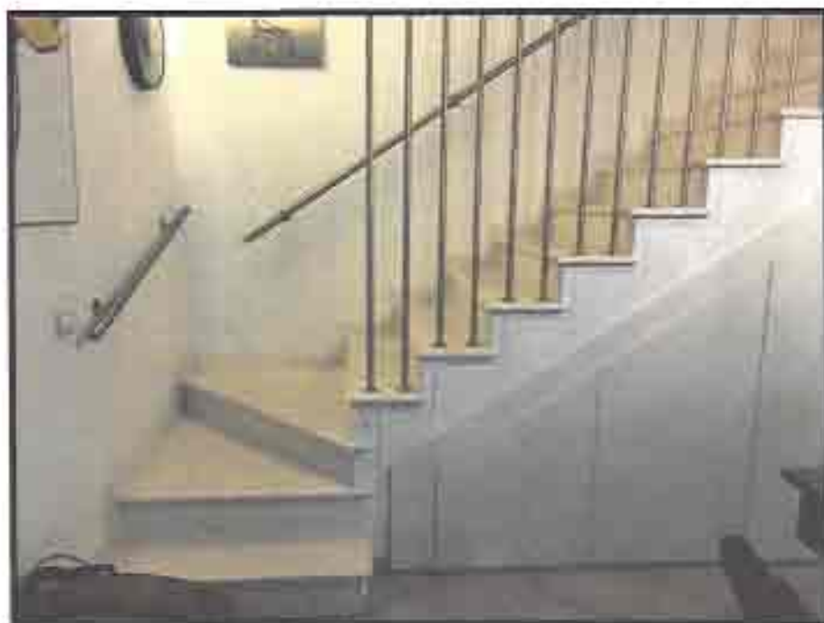
Figure 19: particolare delle scale .
