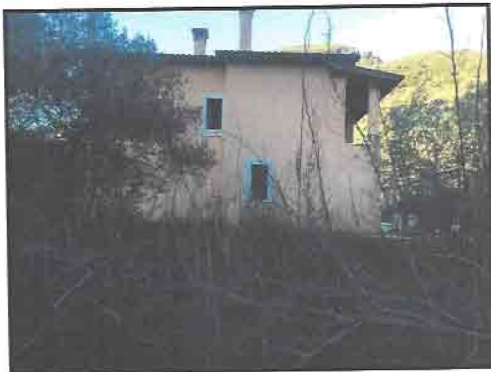
Figura 4: prospetto laterale all'immobile oggetto di perizia.
