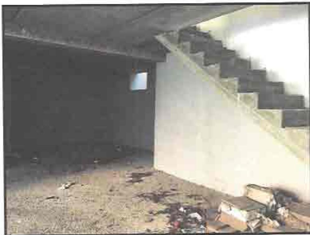
Figura 10: particolare delle scale che collegano il piano terra al seminterrato
