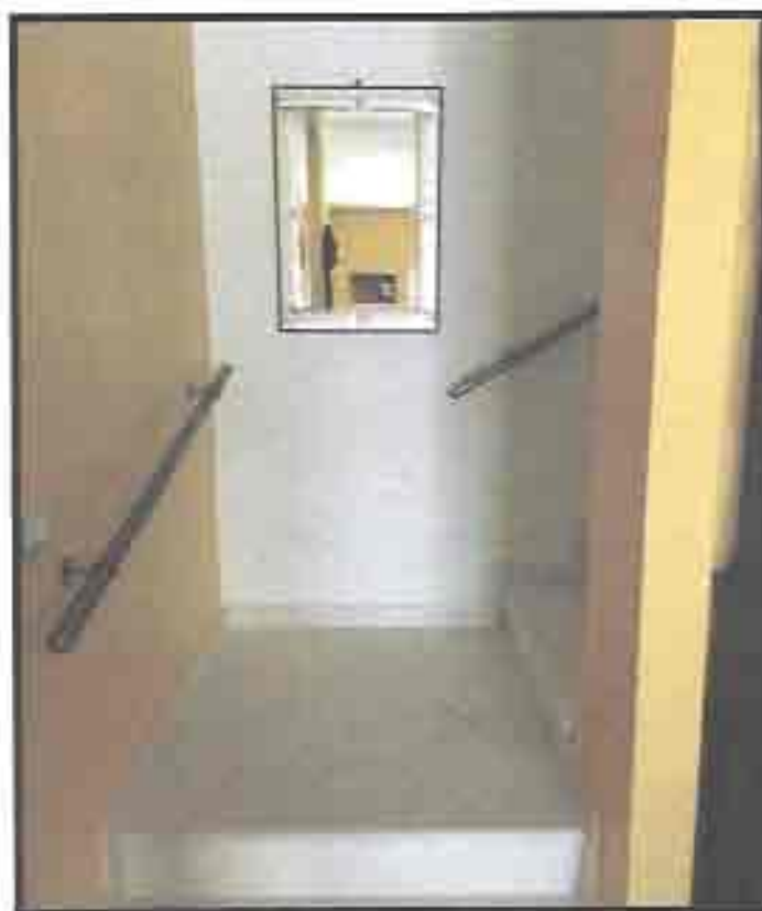
Figura 21: particolare della scala che collega il piano terra al piano primo.
