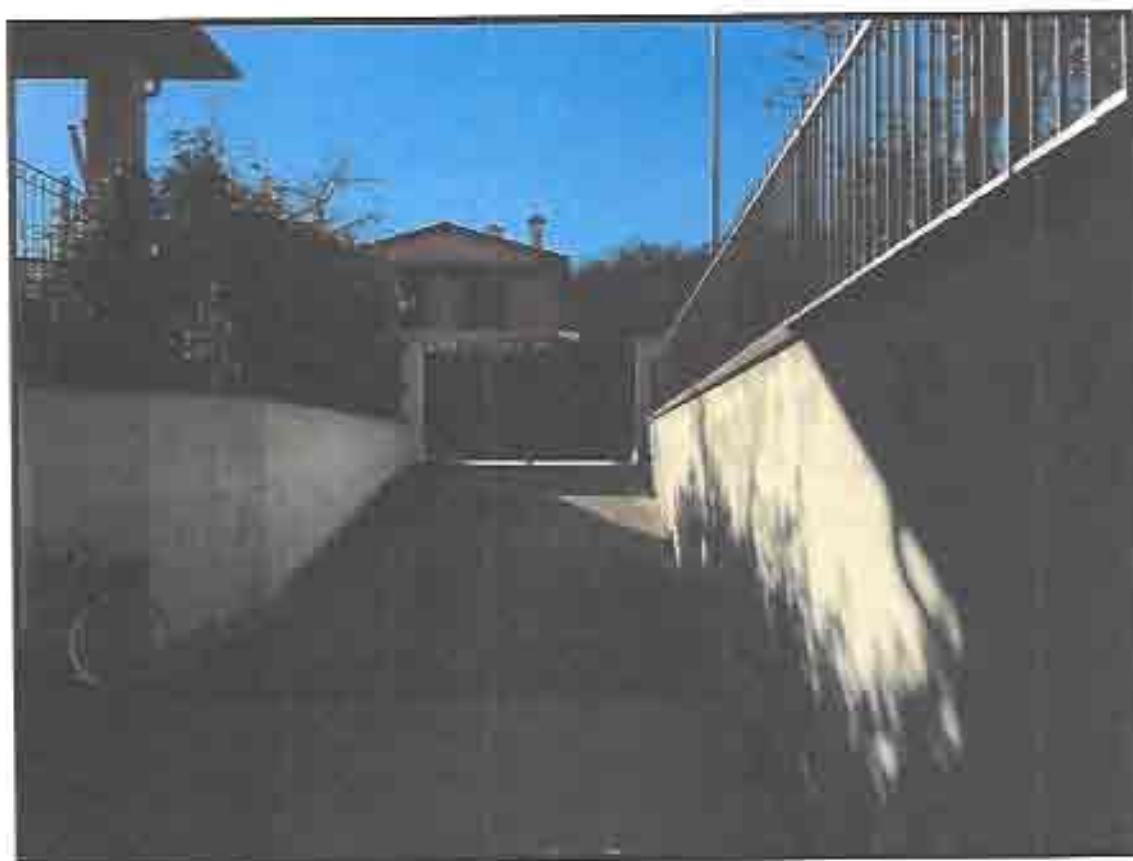
Figura 2: particolare rampe per l'ingresso al garage.
