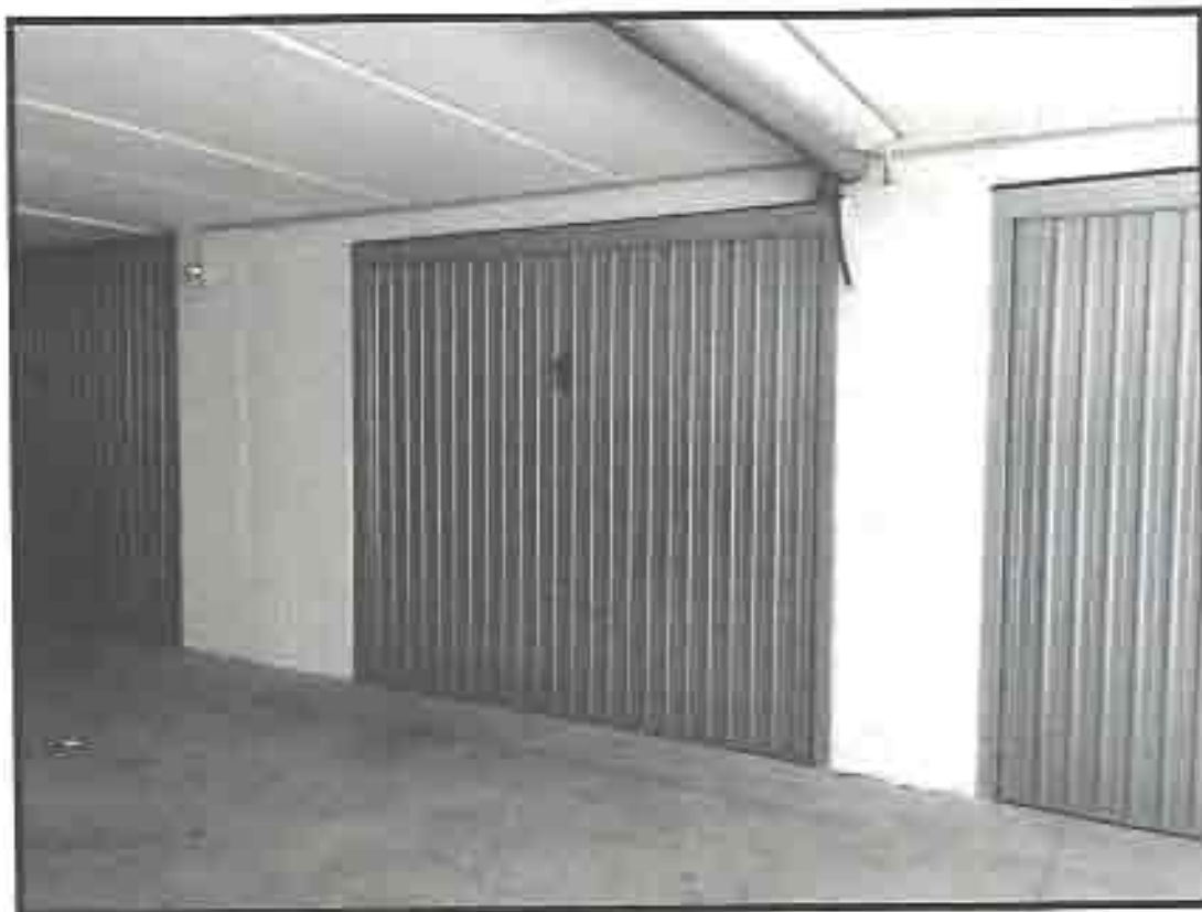
Figura 3 particolare ingresso garage.
