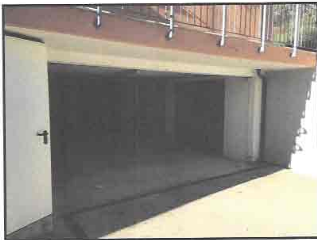
Figura 2 particolare ingresso corsia garage:
