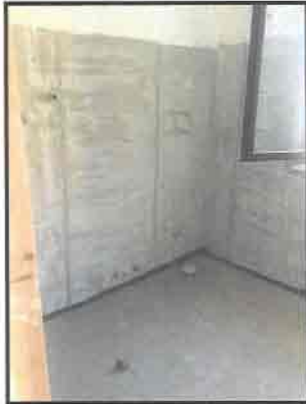
Figura 9: particolare del bagno.
