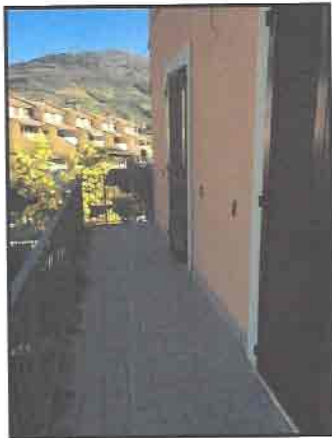
Figura 22: particolare secondo balcone esterno.
