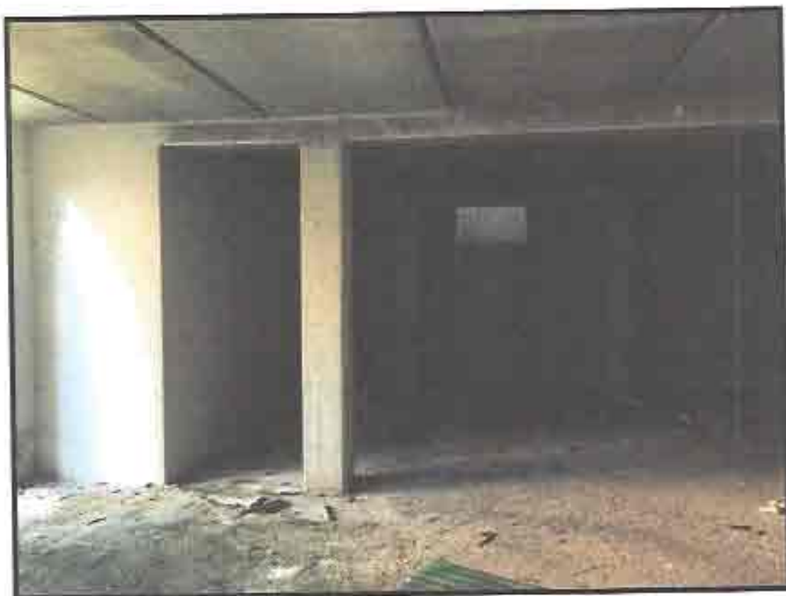
Figura 9: piano interrato dell'abitazione oggetto di perizia.
